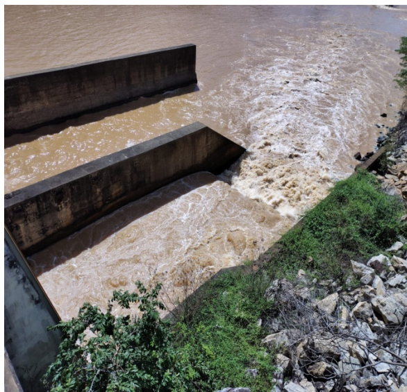
Descarga de fundo da Barragem e saída da água turbinada
