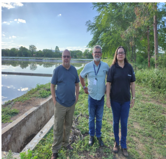
Instalações da ETE da EMBASA em Jequié
