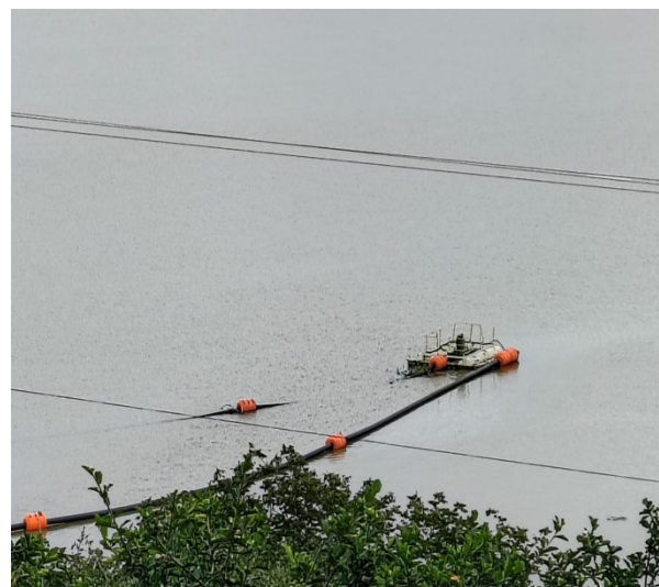
Captação da Largo Vanádio de Maracás no Lago da Barragem
