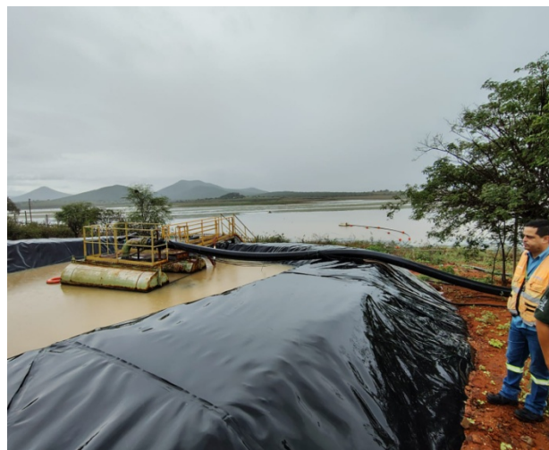
Reservatório da Largo Vanádio de Maracás às margens do Lago da Barragem UHE Pedra
