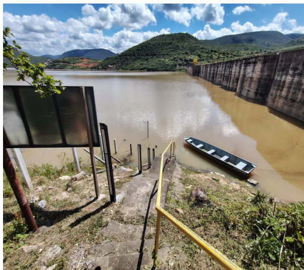
Lago da Barragem com régua de monitoramento das cotas
