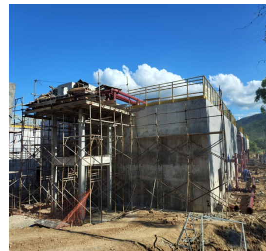
Obra de instalação de DAFs na ETE da EMBASA em Jequié
