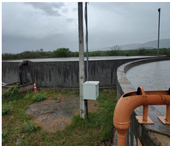
Reservatório nas instalações da Largo Vanádio de Maracás - Maracás
