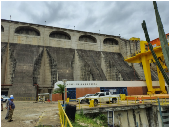
Barragem UHE Pedra - Jequié
