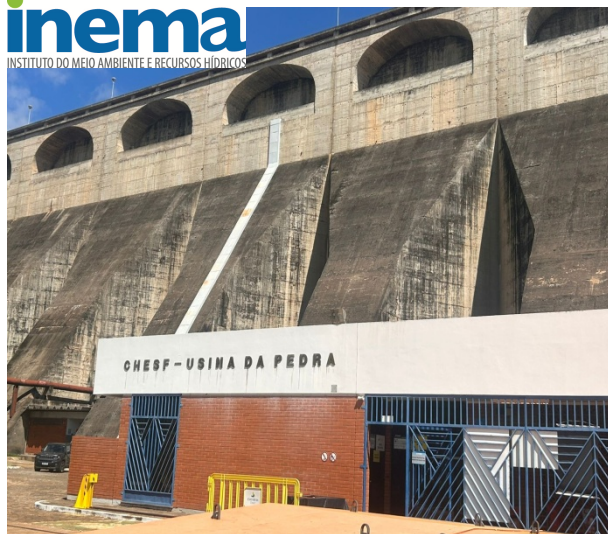
Barragem UHE Pedra
