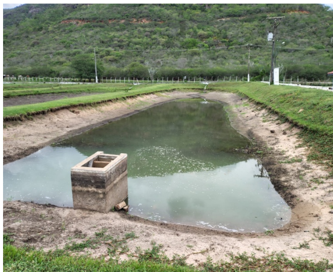
Tanque escavado nas instalações da Bahia Pesca - Jequié
