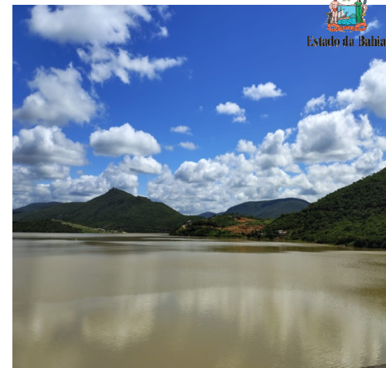
Lago da Barragem – vista a montante da Barragem UHE Pedra
