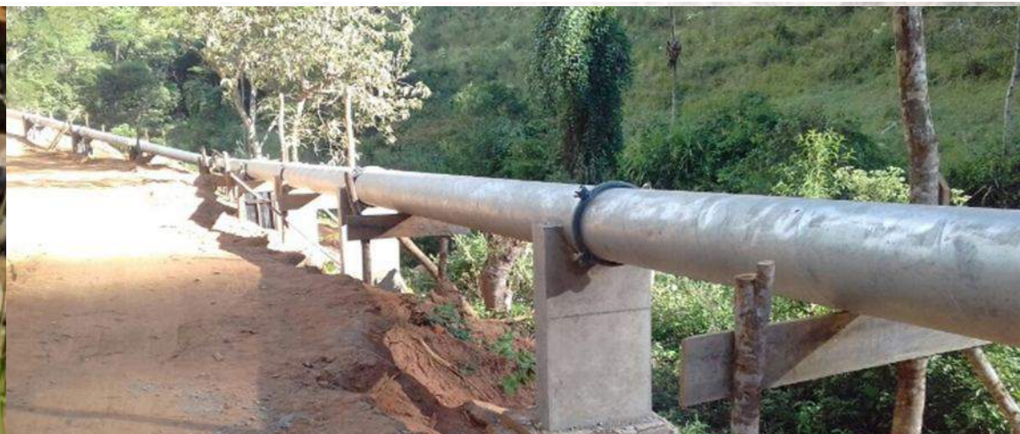
Adutora do Gaviãozinho - Tubos assentados de engate rápido – V. Conquista
