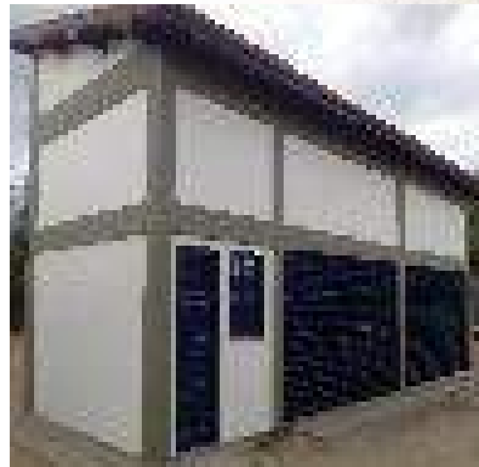
SIAA Boquira / 1ª Etapa - Casa de Cloração
