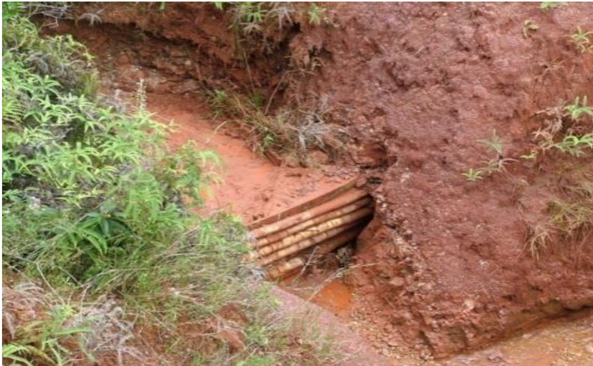
Figura 17 – Exemplo de paliçada de bambu em funcionamento. Observa-se o barramento e acúmulo de sedimentos à montante da enxurrada.
