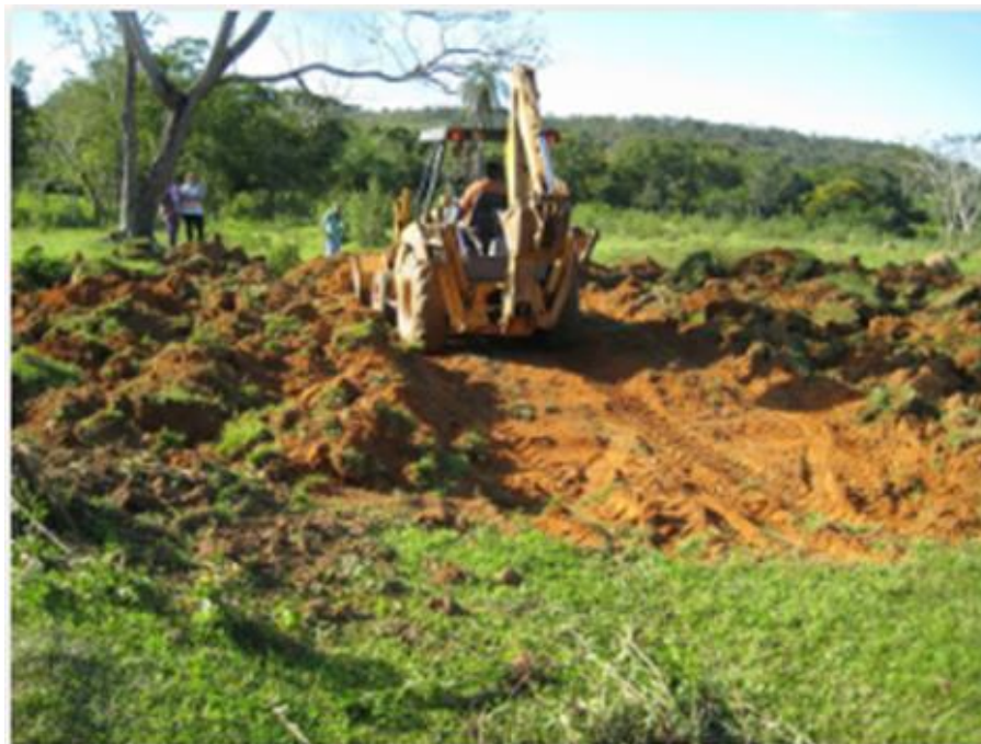
Figura 7 – Exemplo de maquinário realizando limpeza inicial de área a ser escavada para construção de barraginha.
