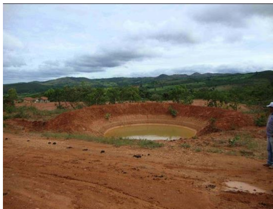
Figura 26 – Barraginha integrante de requalificação da malha viária no Município de Guaraciama, MG (AGB Peixe Vivo, 2012)
