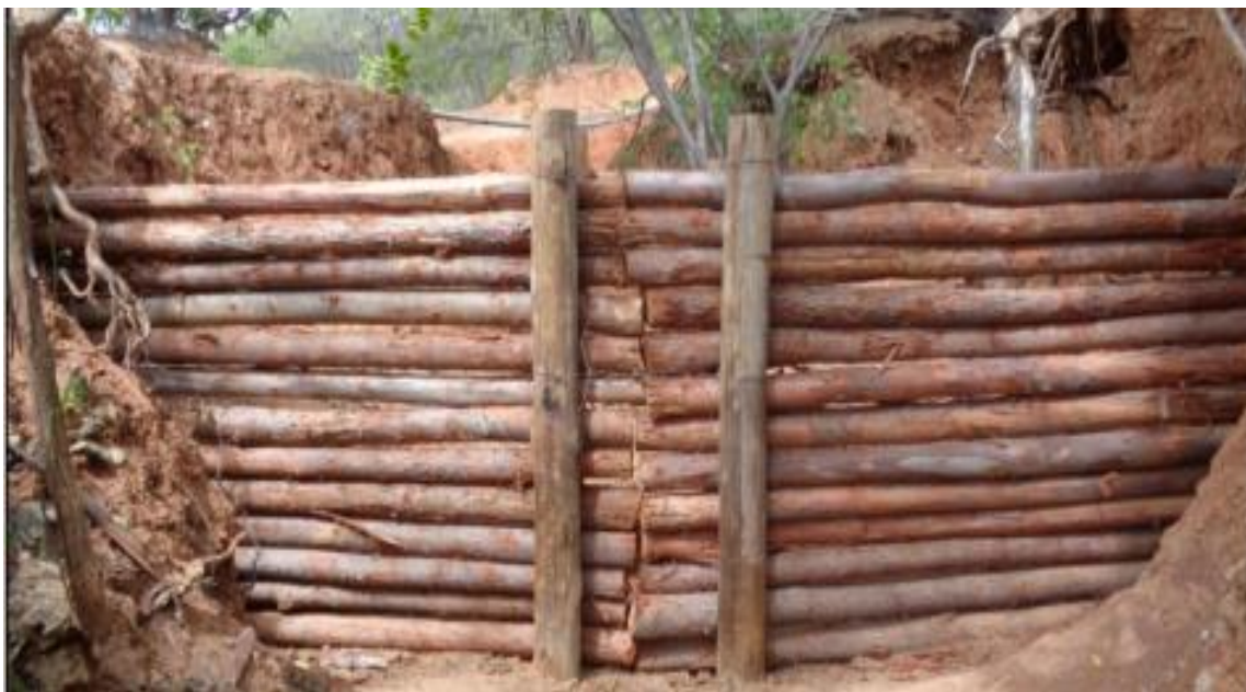
Figura 12 – Exemplo de paliçada de madeira com peças dispostas horizontalmente, formando um “cortinamento” para contenção de sedimentos.
