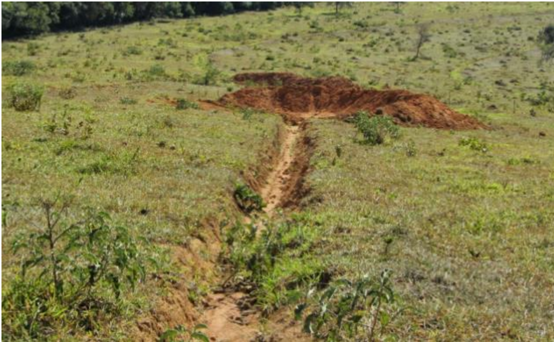
Figura 10 – Exemplo de canal escavado para condução de águas de enxurradas para barraginha.
