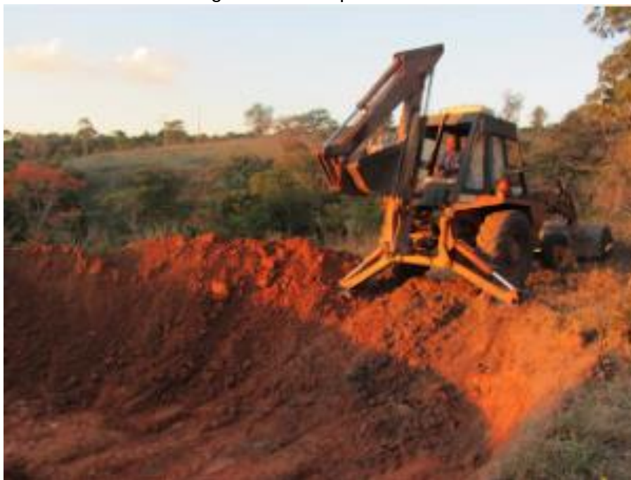
Figura 8 – Exemplo de escavação da barraginha propriamente dita com uso de retroescavadeira.
