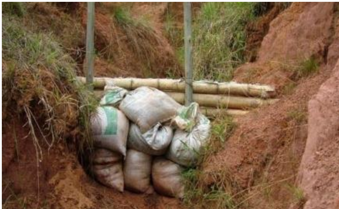
Figura 15 – Exemplo de paliçada de bambu. Observa-se a disposição de sacos de ráfia preenchidos com terra para reforçar o escoramento e promover a absorção do impacto das enxurradas.
