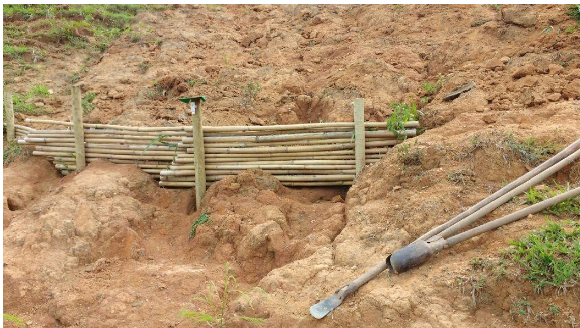
Figura 14 – Exemplo de paliçada de bambu. Observa-se a disposição dos mourões (vertical) e das peças de bambu (horizontal), formando uma “cortina” de barramento.
