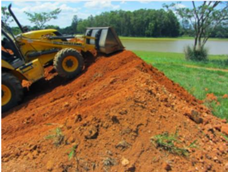
Figura 9 – Exemplo de maquinário realizando a compactação da crista da bacia recém-formada.
