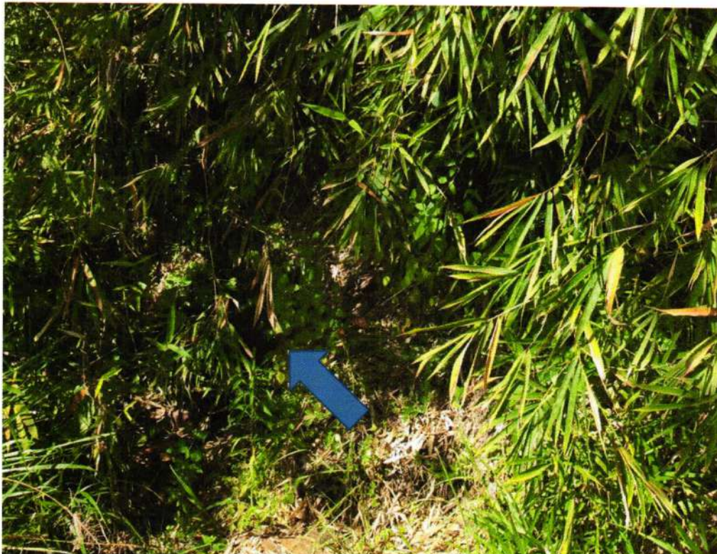
Entrada do BST no km 20,022 – Vegetação impedindo a inspeção detalhada.
