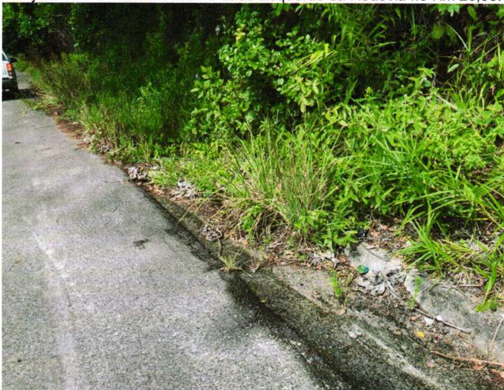
Sarjeta STC 03 identificada no Lado Esquerdo da Rodovia no Km 26,98.
