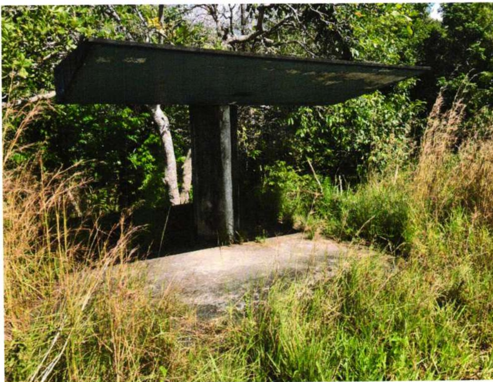
Abrigo padrão DERBA – Km 27,420. Estrutura íntegra.
