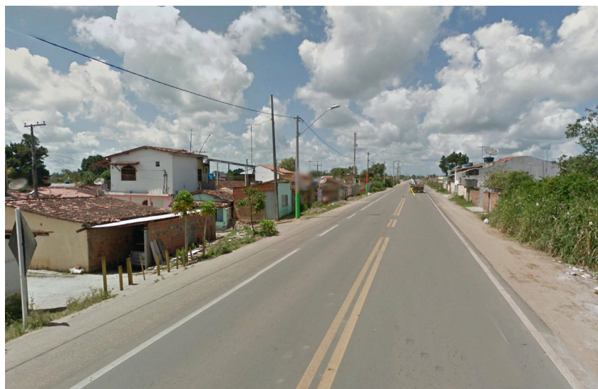
Foto 22 Ocupações à margem da rodovia.
