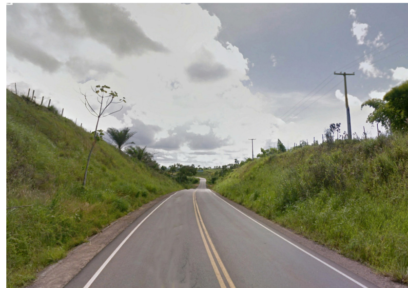
Foto 10 Rodovia sem acostamento
