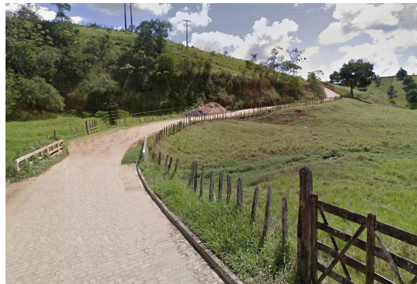
Foto 29 BA-497 no trecho inicial sem ocupação lindeira.
