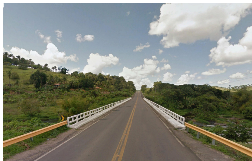
Foto 6 Ponte sem acostamento
