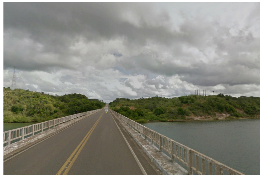
Foto 1 Ponte do Funil sem acostamento
