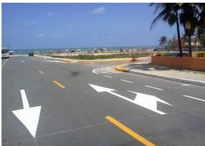
Figura 53 – Detalhe de sinalização horizontal (faixas, setas e zebraados)
