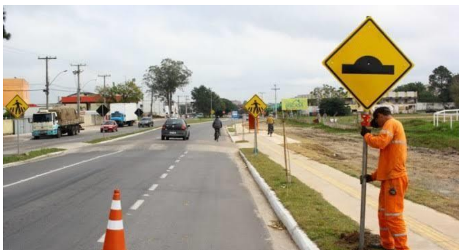
Figura 52 – Implantação de sinalização vertical
