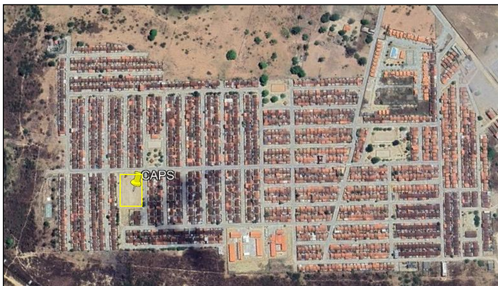
Figura 13 – Foto da área de implantação do CAPS
