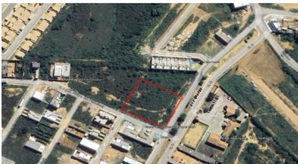
Figura 14 – Foto da área de implantação da UBS
