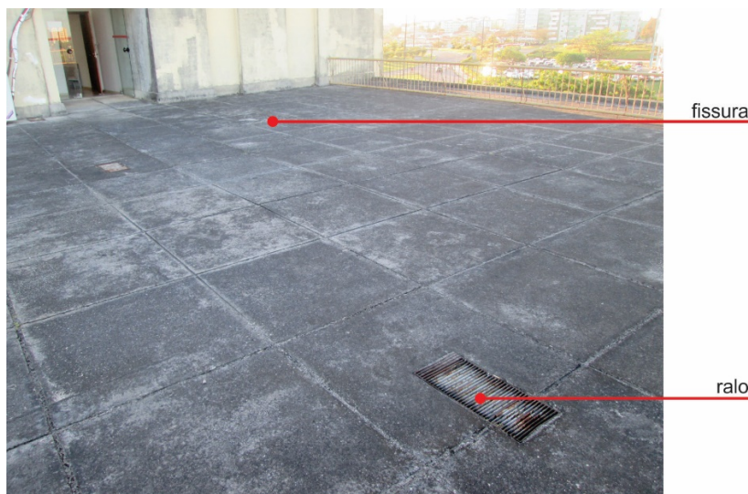
Terraço 2º pavimento
