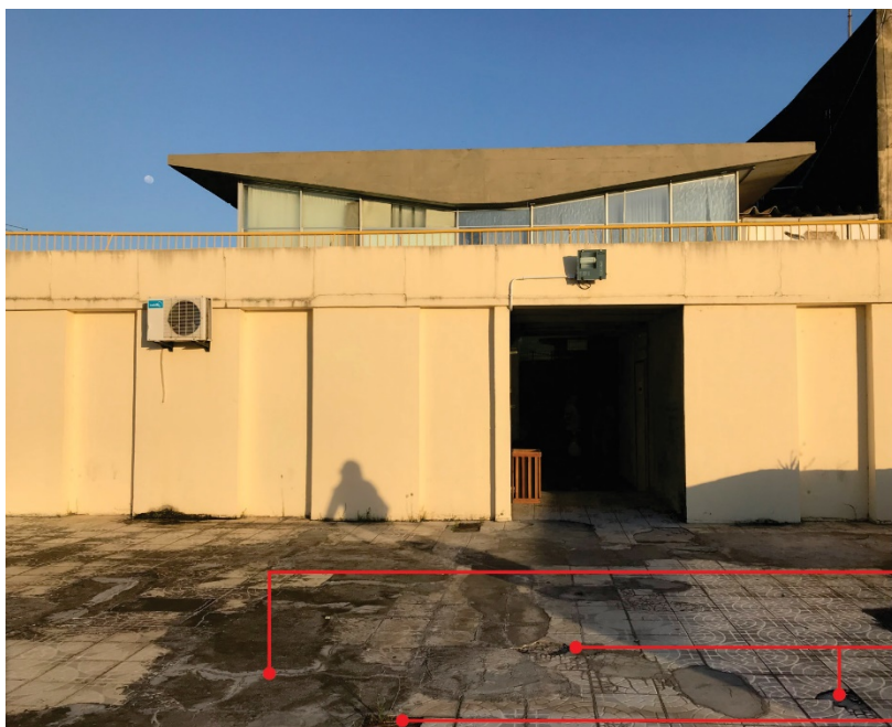
Terraço 3º pavimento
