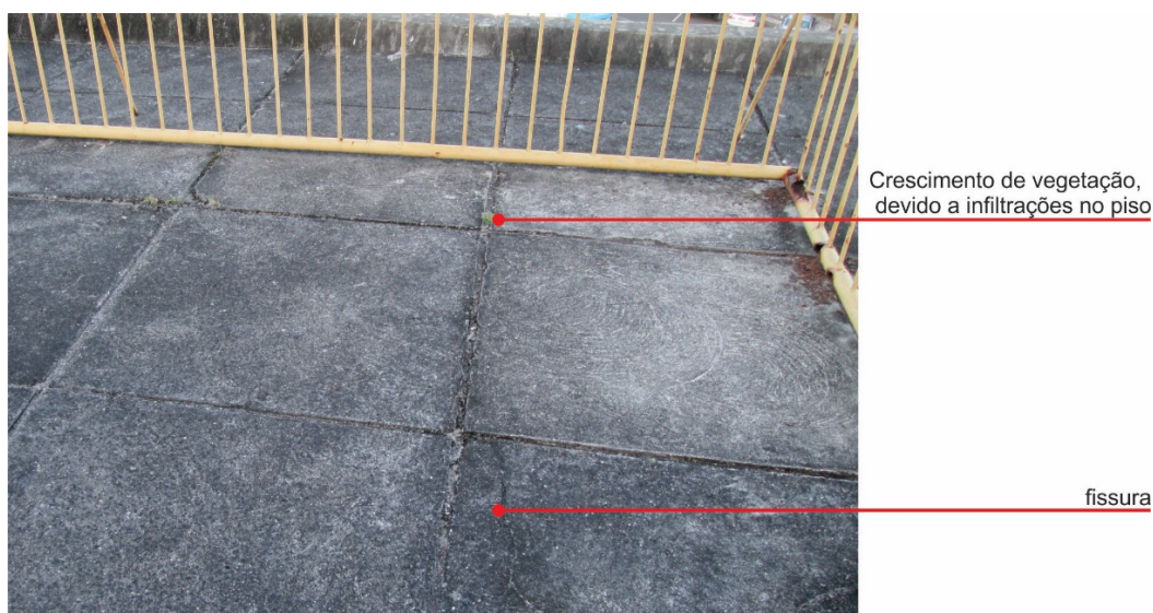
Terraço 2º pavimento
