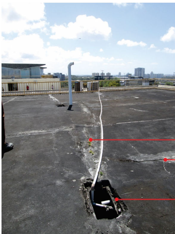
Terraço 4º pavimento
