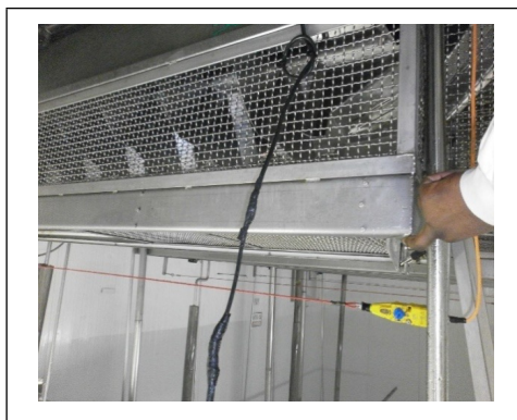
Figura 3: Maquinário dotado de sistema de proteção de segurança e dispositivo de intertravamento com bloqueio capaz de impedir o acesso do operador à zona de perigo
