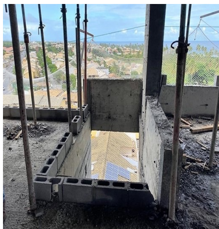
Periferia da edificação sem a instalação de proteção contra queda de trabalhadores e contra a projeção de materiais
