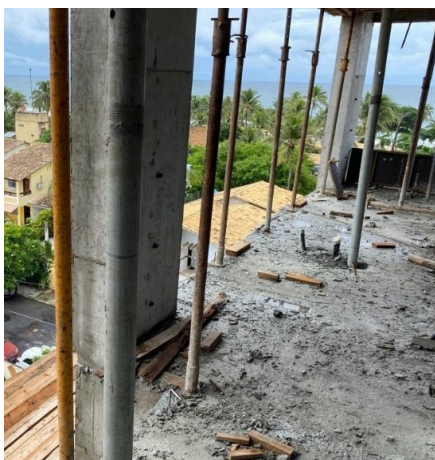
Periferia da edificação sem a instalação de proteção contra queda de trabalhadores e contra a projeção de materiais
