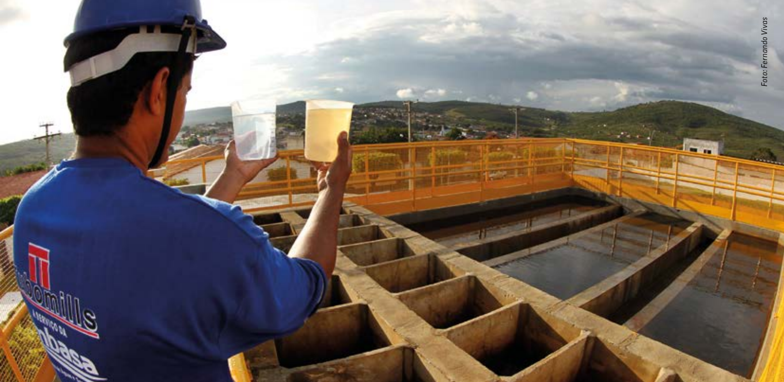
Obras de ampliação do sistema de abastecimento de água, em Boa Nova
