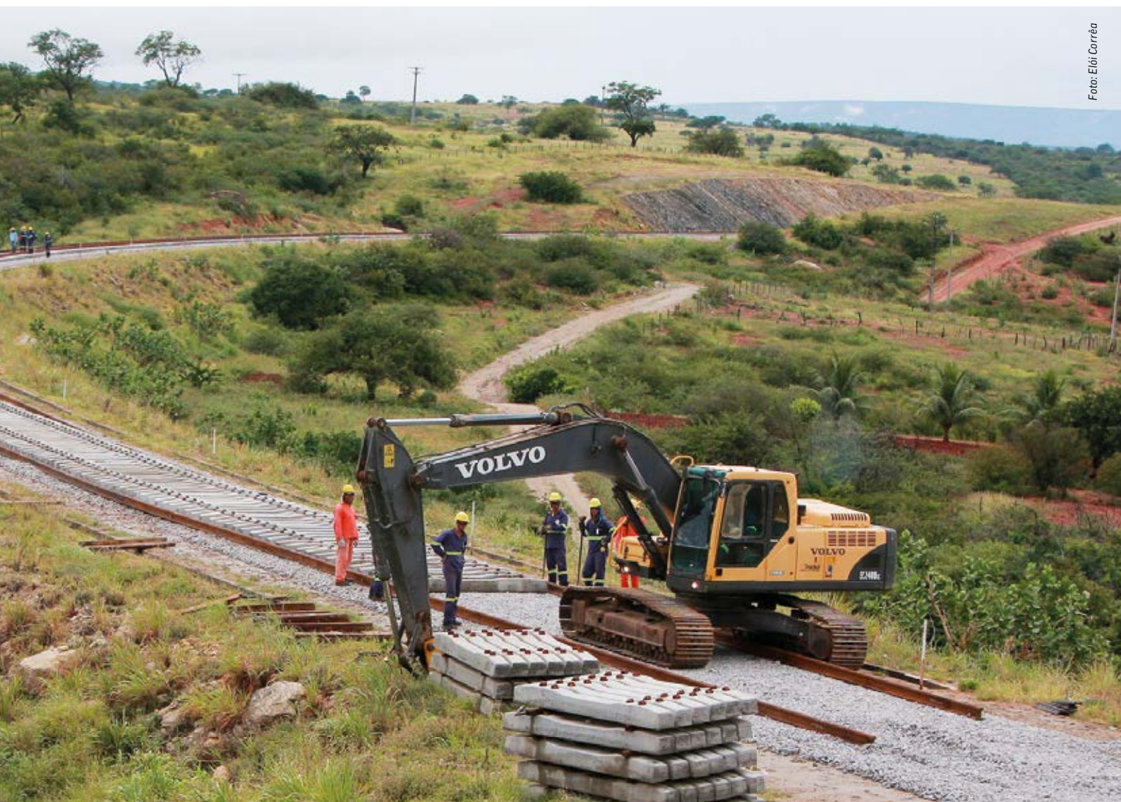
Obras da Ferrovia de Integração Oeste-Leste em Tanhaçu
