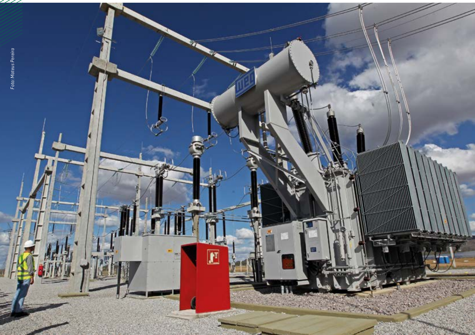
Usina solar em Juazeiro
