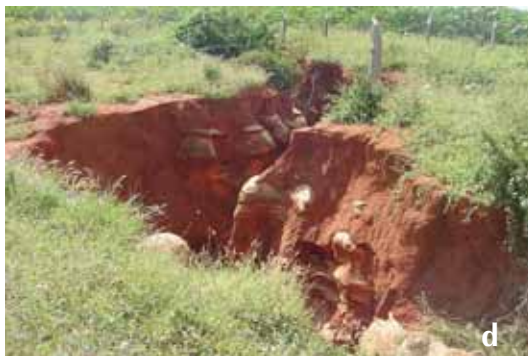
Figura 5 - Eventos erosivos de ocorrência no semi-árido da Bahia, região de Irecê: a) erosão laminar severa em área sob uso com mamona; b) voçoroca em área com vegetação natural removida para uso com culturas anuais; c) deposição de material erodido com impacto sobre a residência do produtor; d) voçoroca em área de pastagem natural. Fotos: jfmelo
