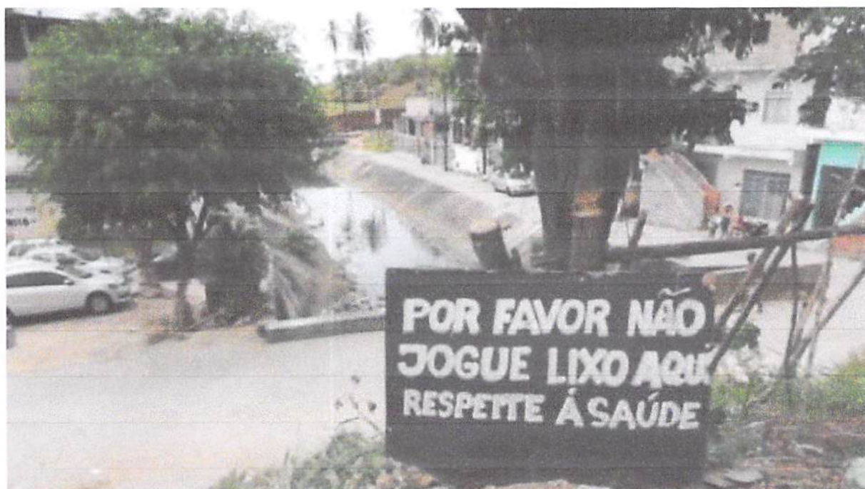
Figura 68 - Acúmulo de lixo no riacho Paripe e na foz do rio Paraguari.
