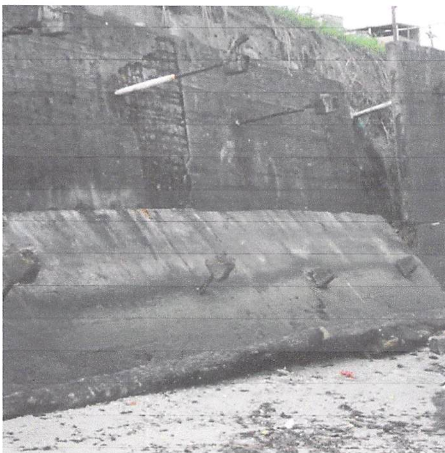
Figura 154- Muro colapsado.
