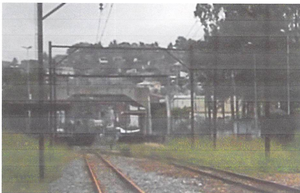
Figura 14 - Estação final do subúrbio ferroviário de Paripe.
