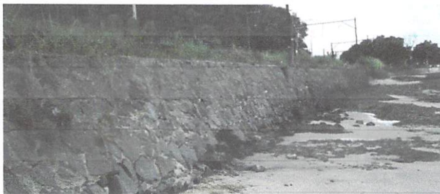
Figura 147 - Vista geral do muro.
