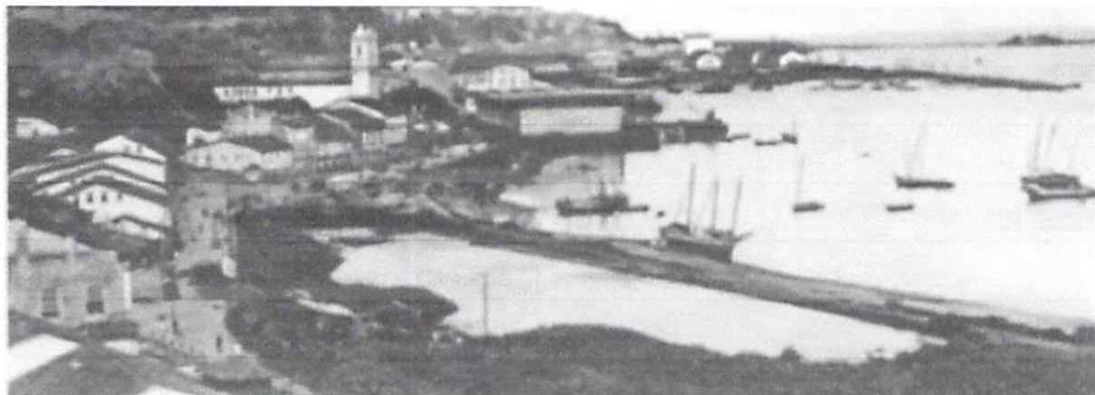
Figura 20 - Início do aterro para construção da avenida Jequitaia em 1920.
