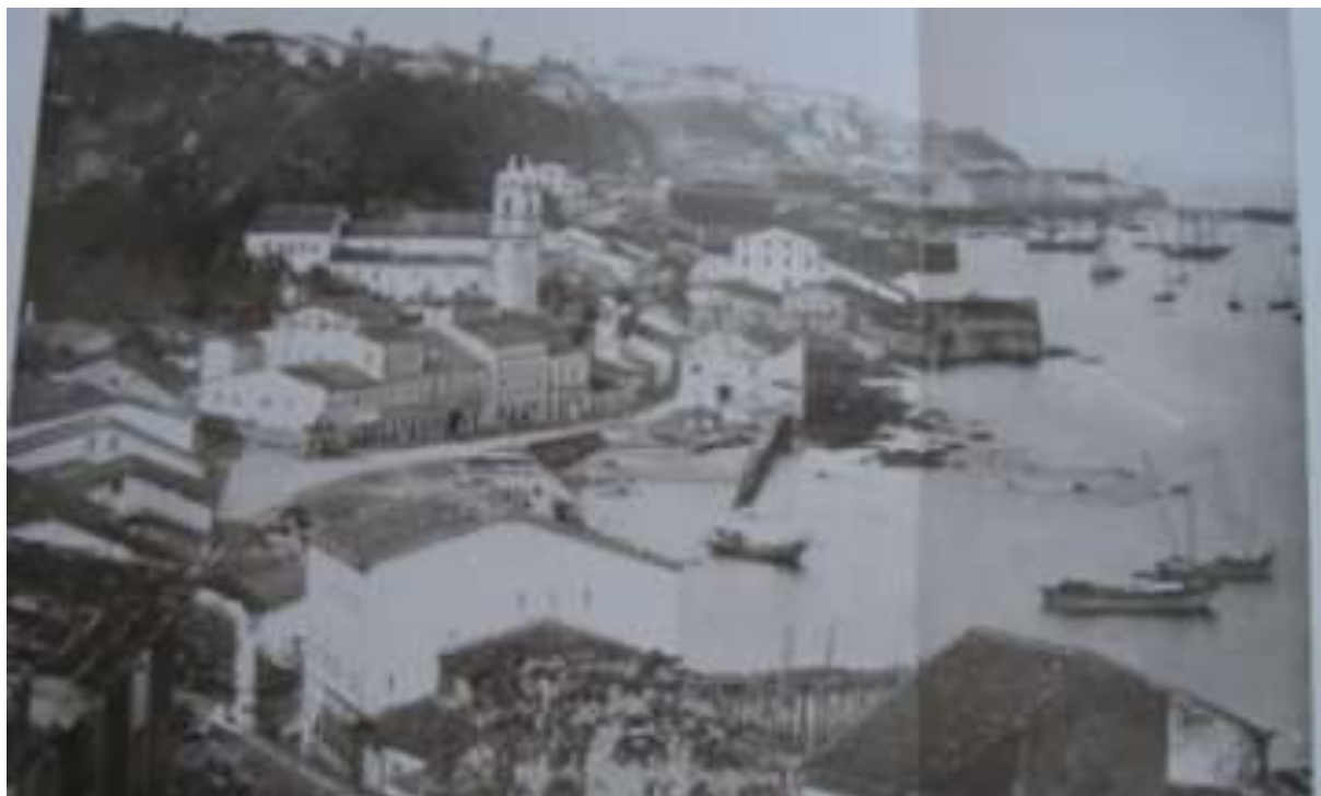
Figura 18 - Área antes do início das obras para construção da av. Jequitaia.
