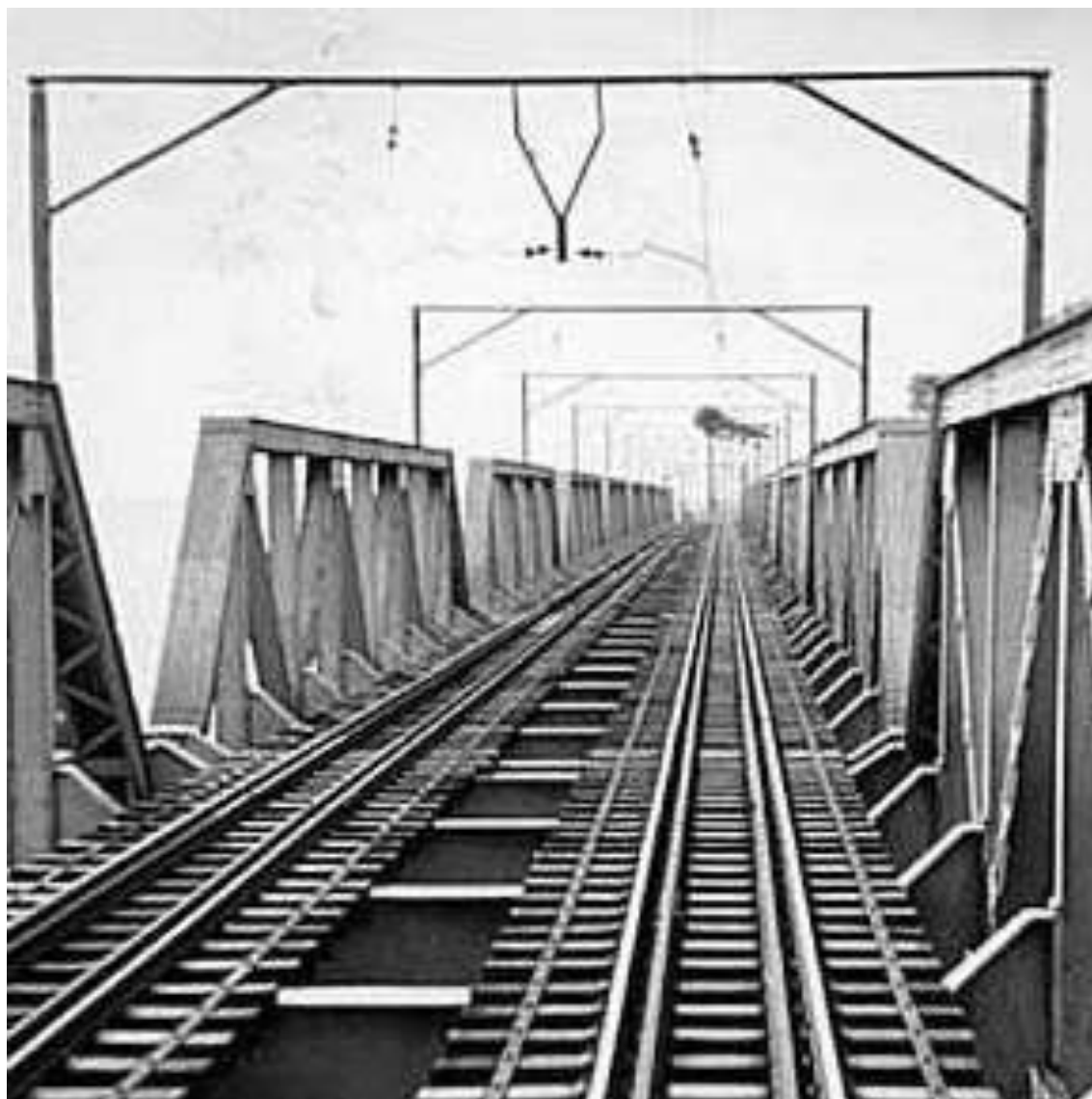
Figura 135 – Antiga Ponte São José.
