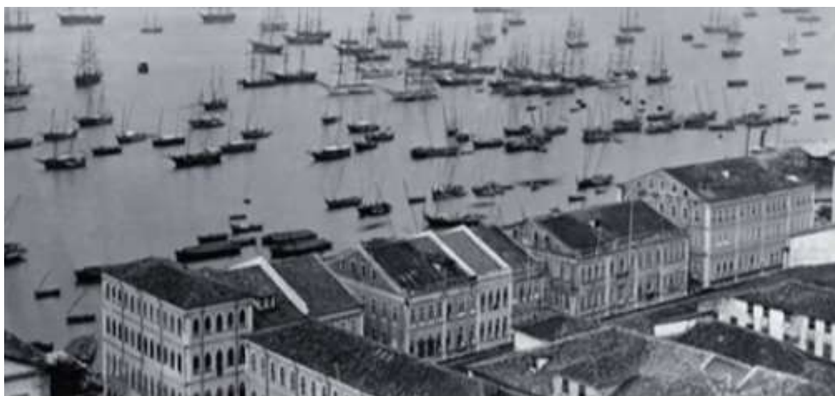
Figura 16 - Área do terminal da França antes do aterro.
