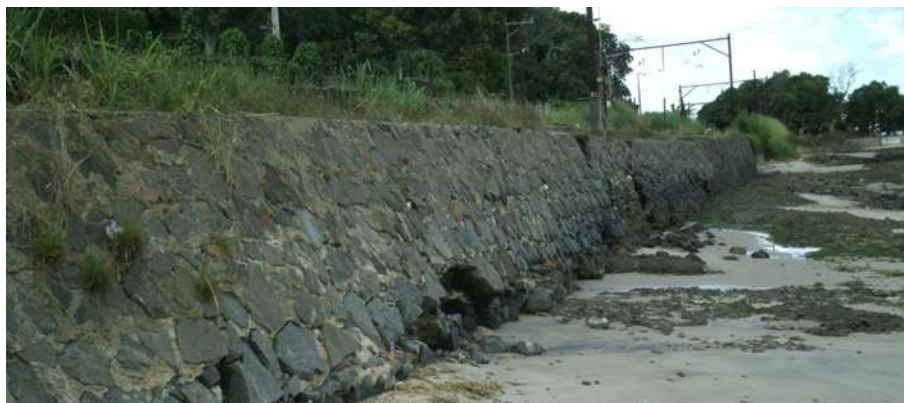
Figura 147 - Vista geral do muro.
