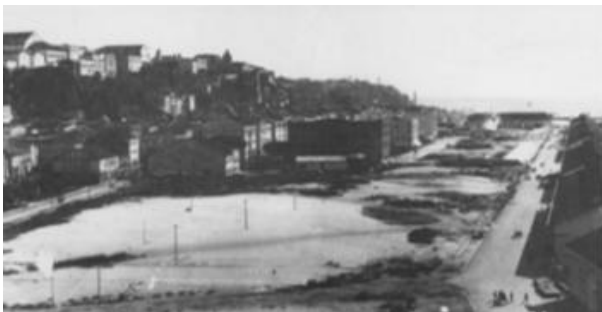
Figura 17 - Área do terminal da França após o aterro
