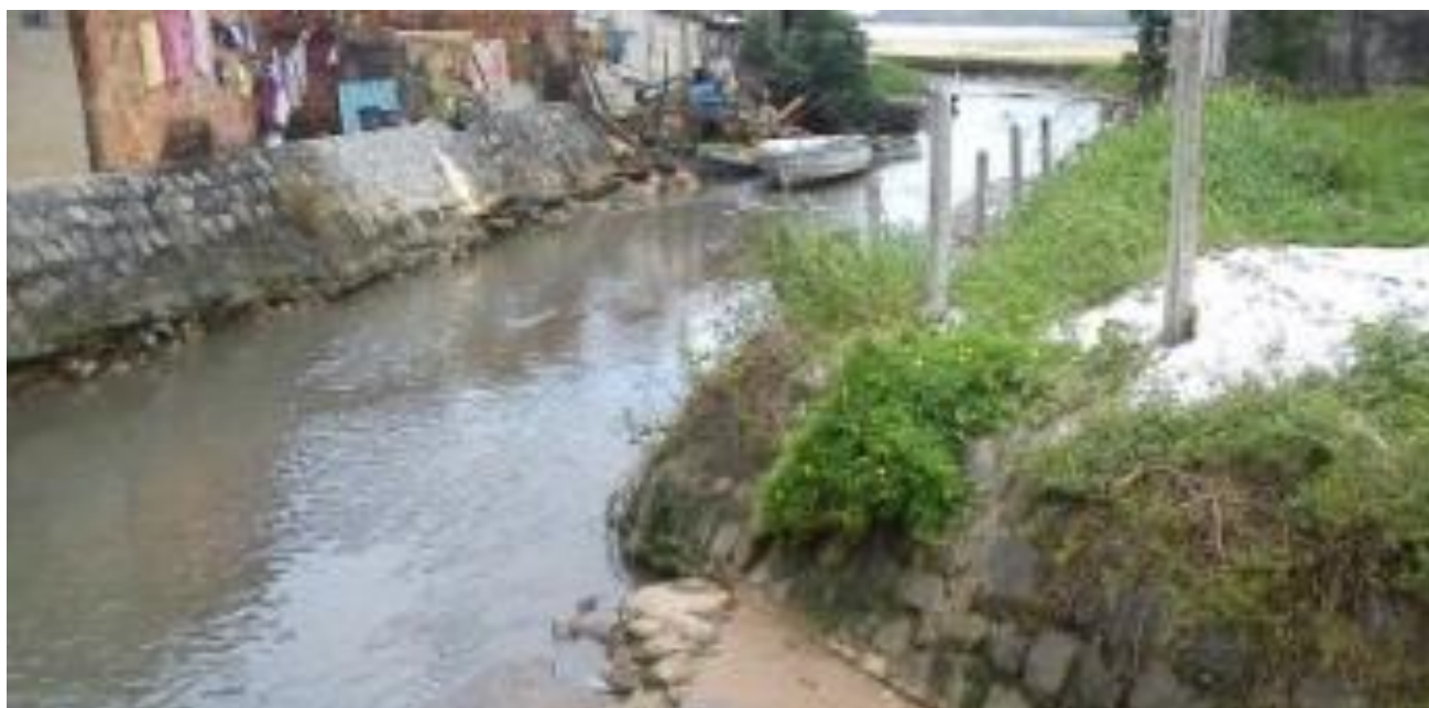
Figura 59 - Captação do rio em tempo seco.
