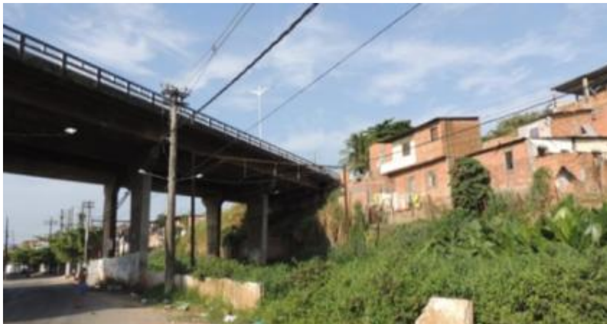
Figura 22 - Ambiente no entorno da linha do trem na passagem pela ponte da via Afrânio Peixoto no bairro do Lobato.
