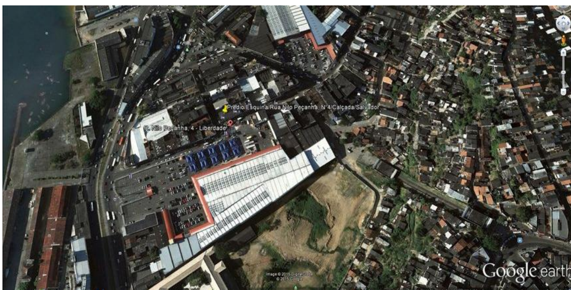
Figura 5 - Vista da região de entorno do bairro da Calçada. Foto: Google Earth.
