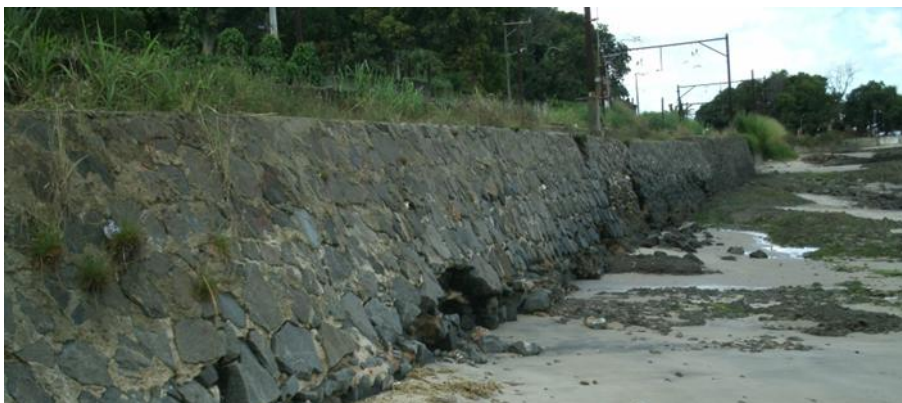
Figura 147 - Vista geral do muro.
