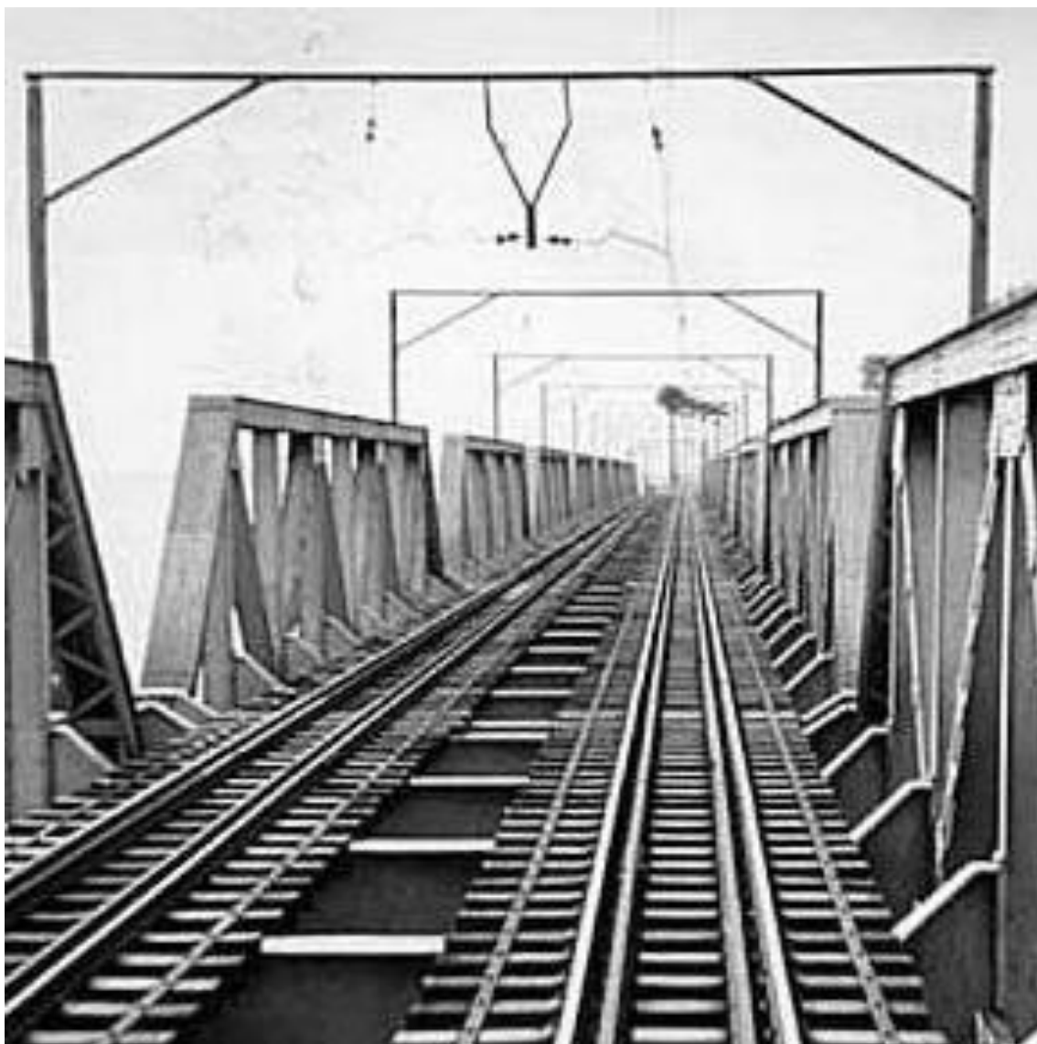
Figura 135 – Antiga Ponte São José.
