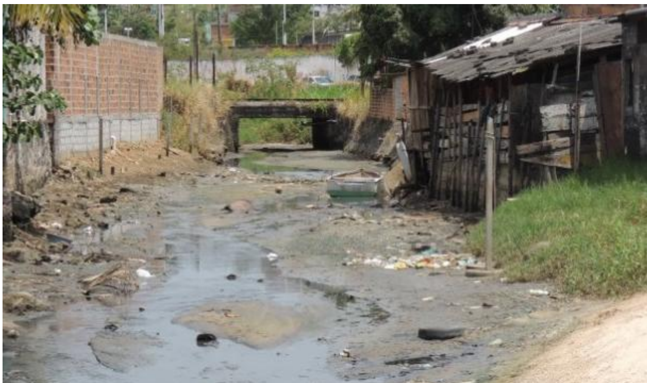
Figura 67 - Acúmulo de lixo no riacho Paripe e na foz do rio Paraguari.
