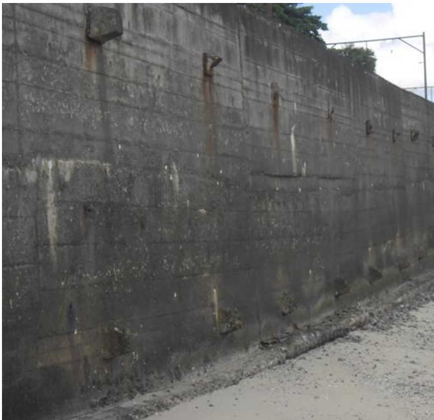
Figura 151 - Muro atirantado (altura variando entre 5,0 e 8,0m).
