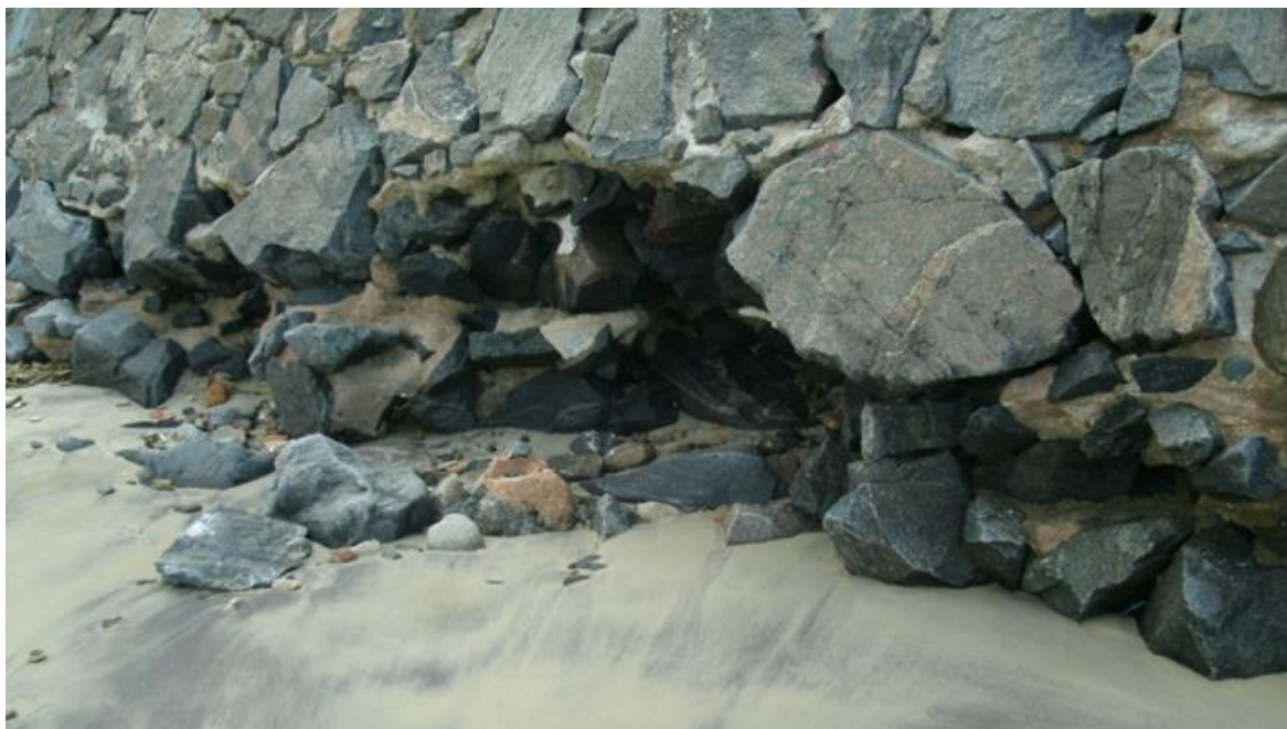
Solapamento da base do muro
