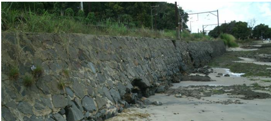
Vista geral do muro de arrimo
