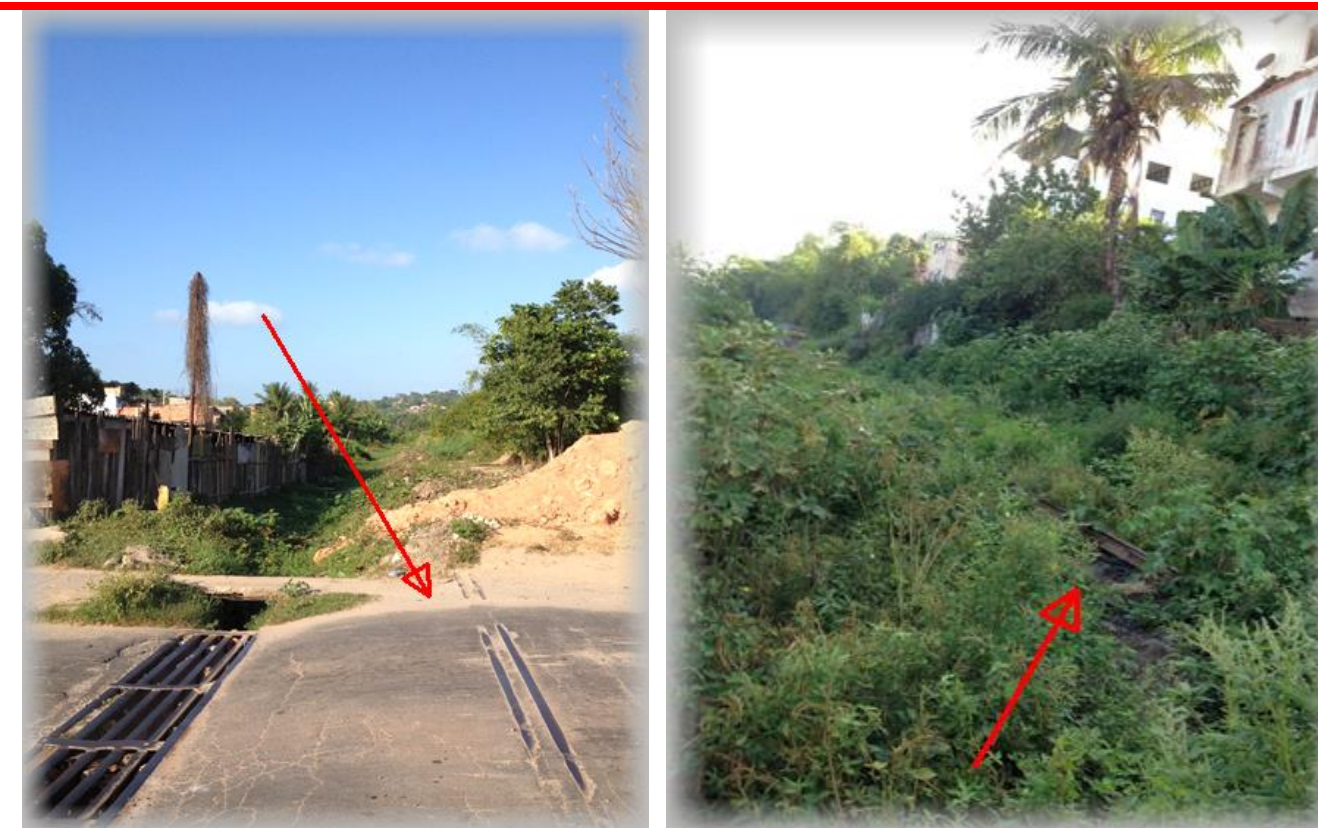
Passagem de Nível e trecho completamente coberto pela vegetação
