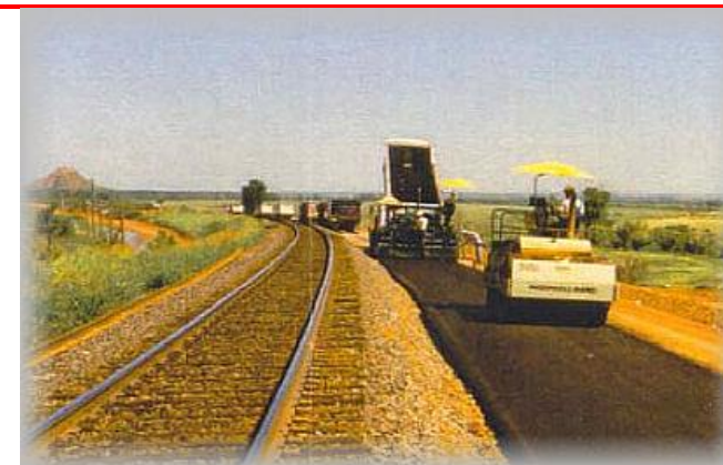
Apoio direto no sub lastro de asfalto ou, mais raramente, de concreto
