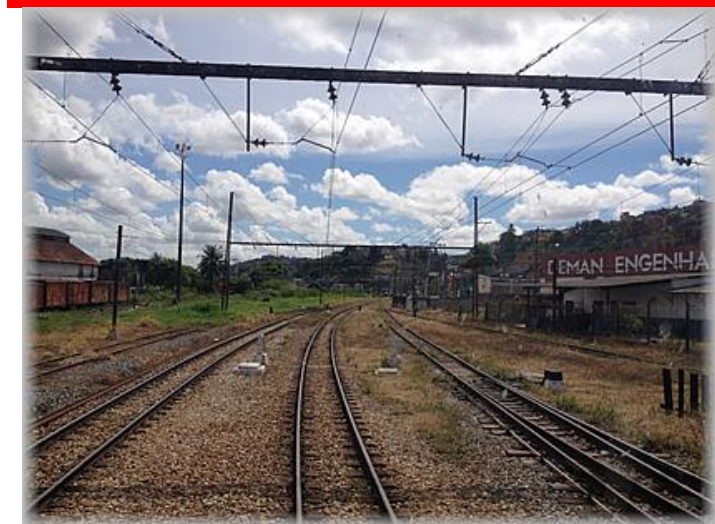
Trecho mostrando as condições atuais da via permanente.
