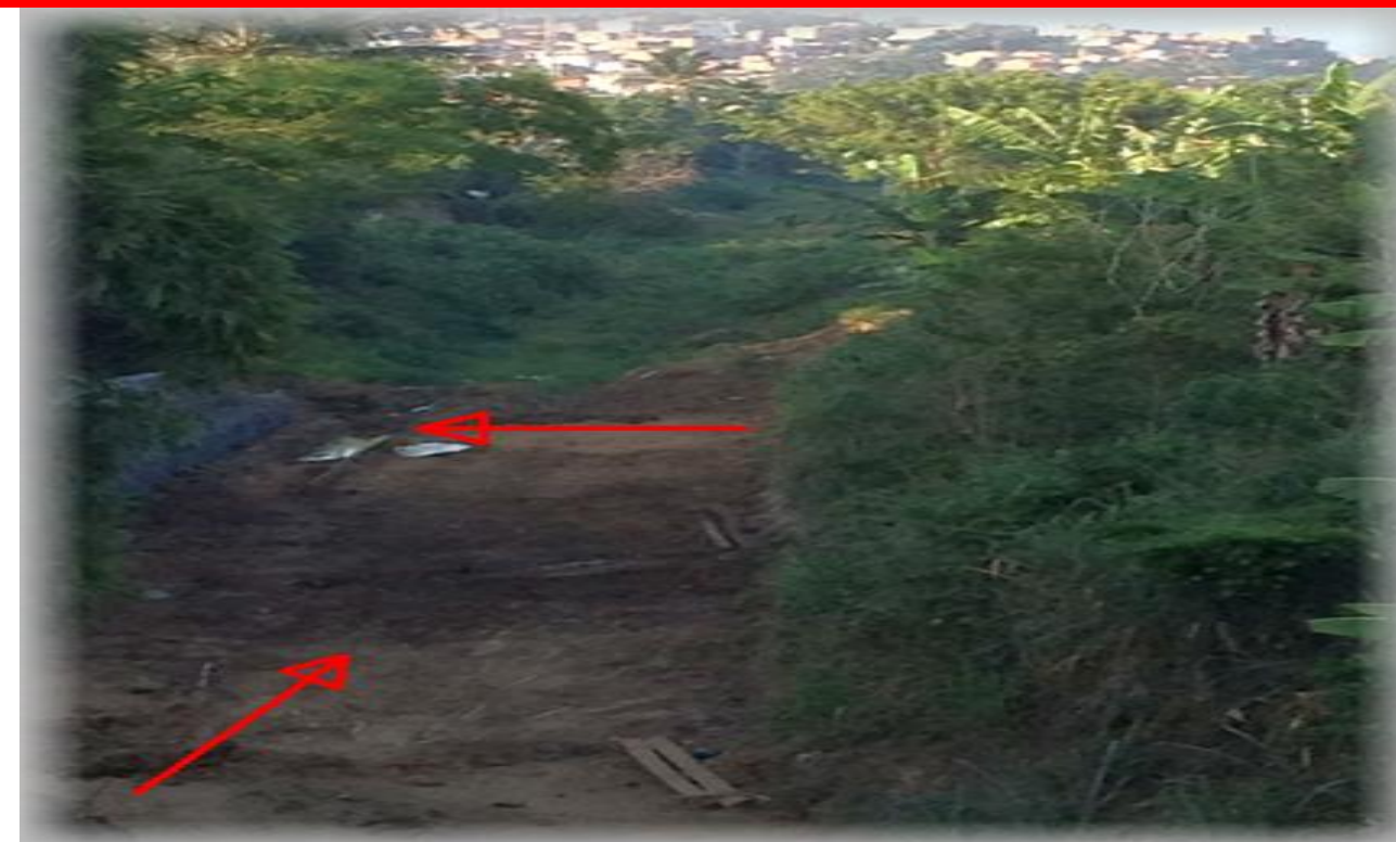
Muro de arrimo em construção para contenção da encosta em Massapê
