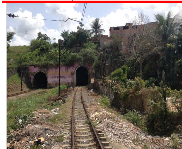
Vista do Túnel Periperi - Paripe.
