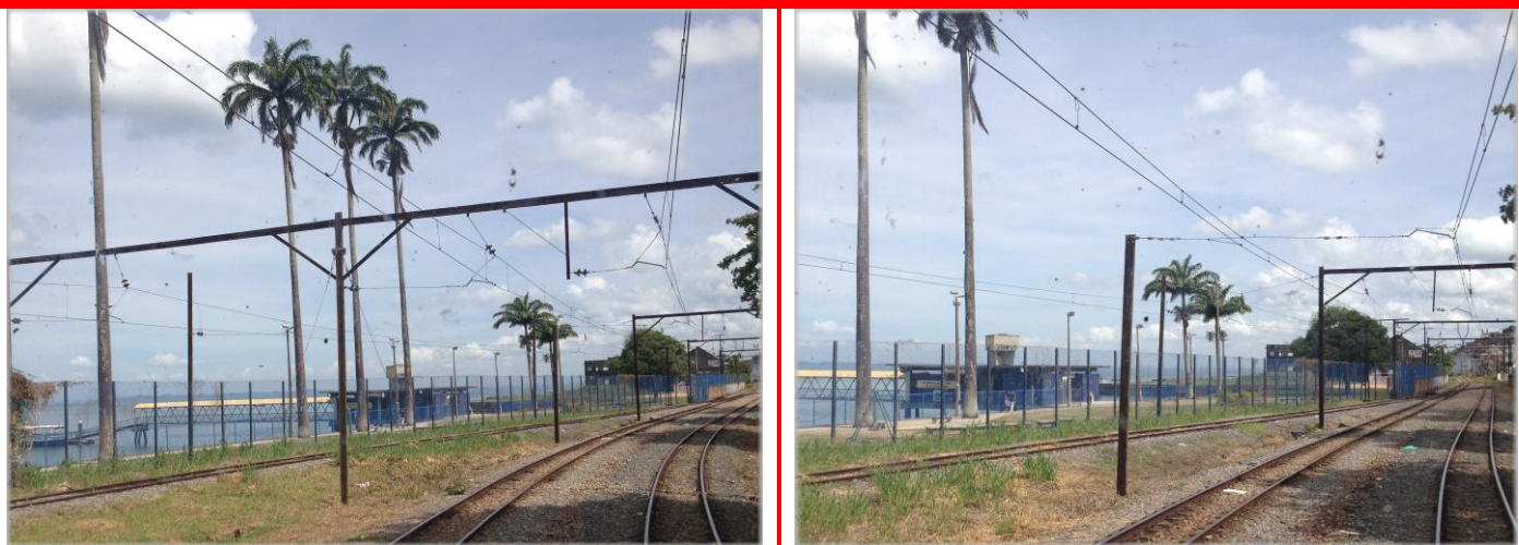
Nas fotos anteriores, pode-se ver o Pier do Terminal Náutico de Plataforma, que deverá ser integrado com uma nova parada a ser implantada, nas proximidades, em frente às antigas ruínas da fábrica de tecidos.
