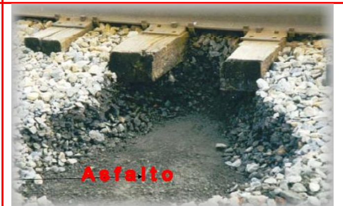
Apoio direto no sub lastro de asfalto ou, mais raramente, de concreto
