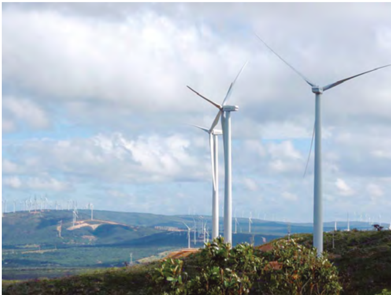
Figura 2 Complexo Eólico Alto Sertão I
