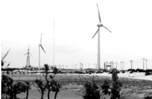
Figura 4 Usina eólica piloto de Macau – Rio Grande do Norte
