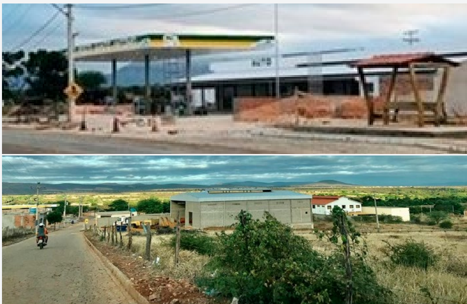
Figura 5 Posto de gasolina e o galpão
