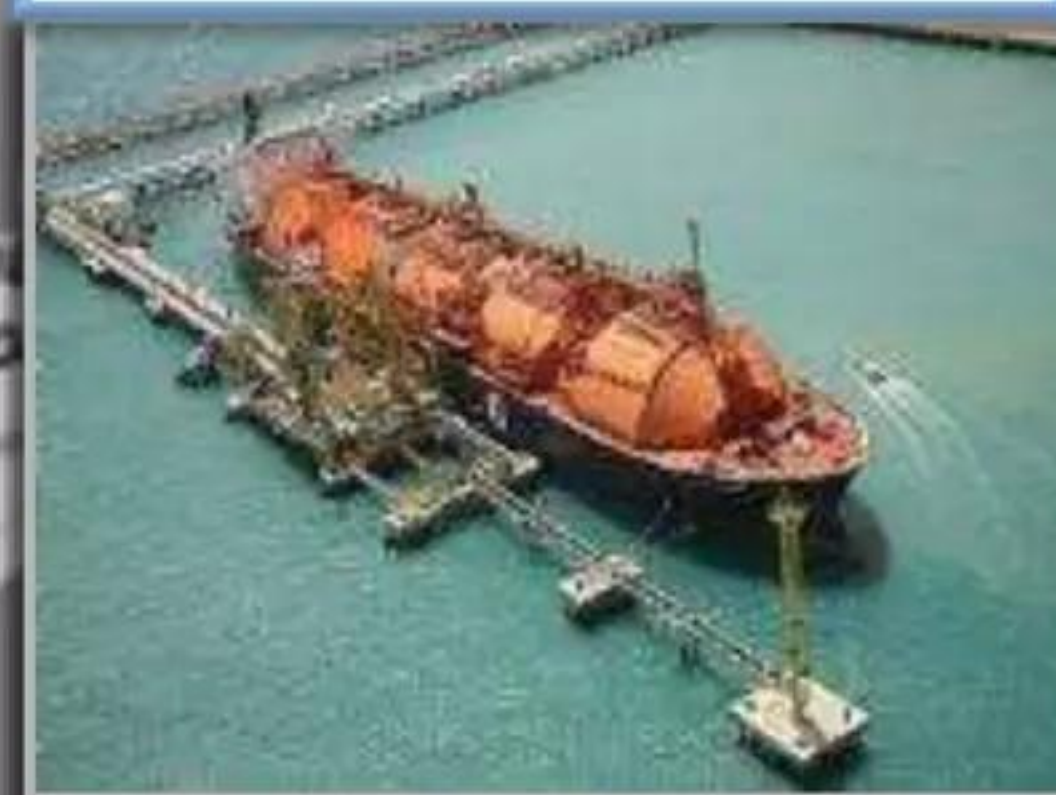
Terminal de Regaseificação
