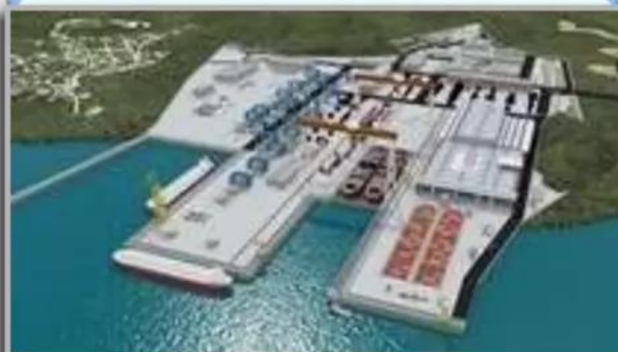
Estaleiro Enseada do Paraguaçu
