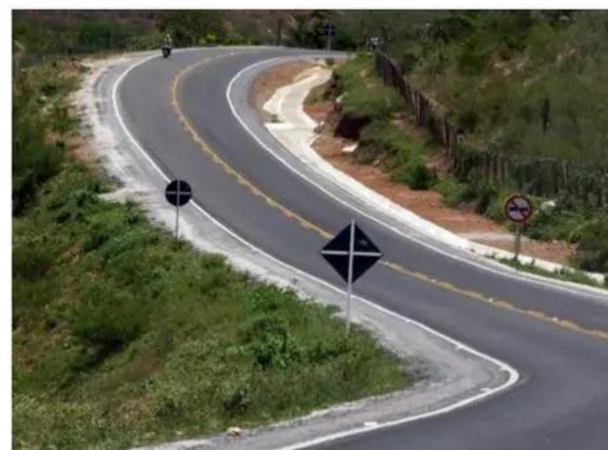
Rodovia BA.120, trecho : Santa Inês - Cravolândia
