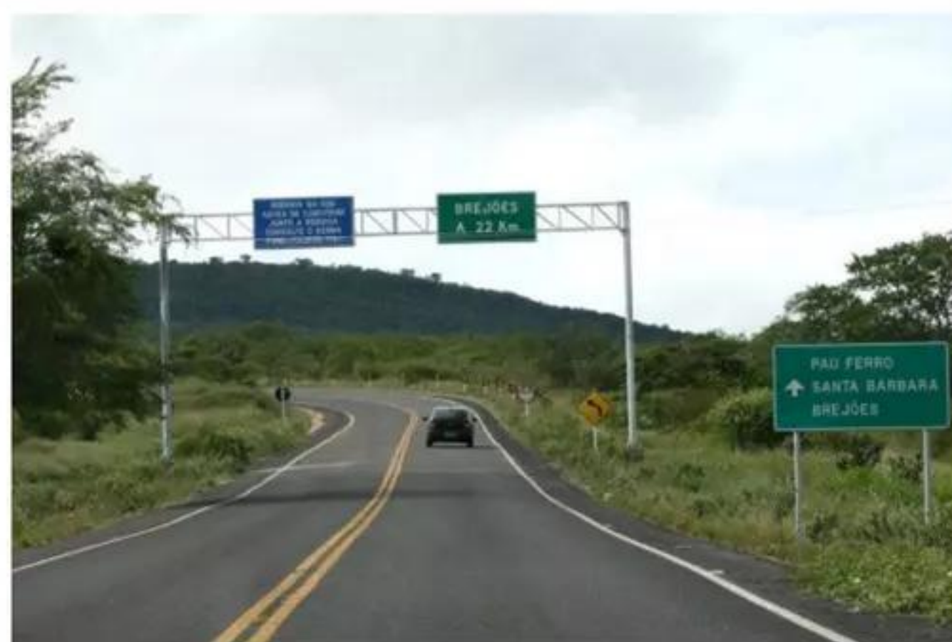
Rodovia BA.026, trecho : BR.116 - Brejões
