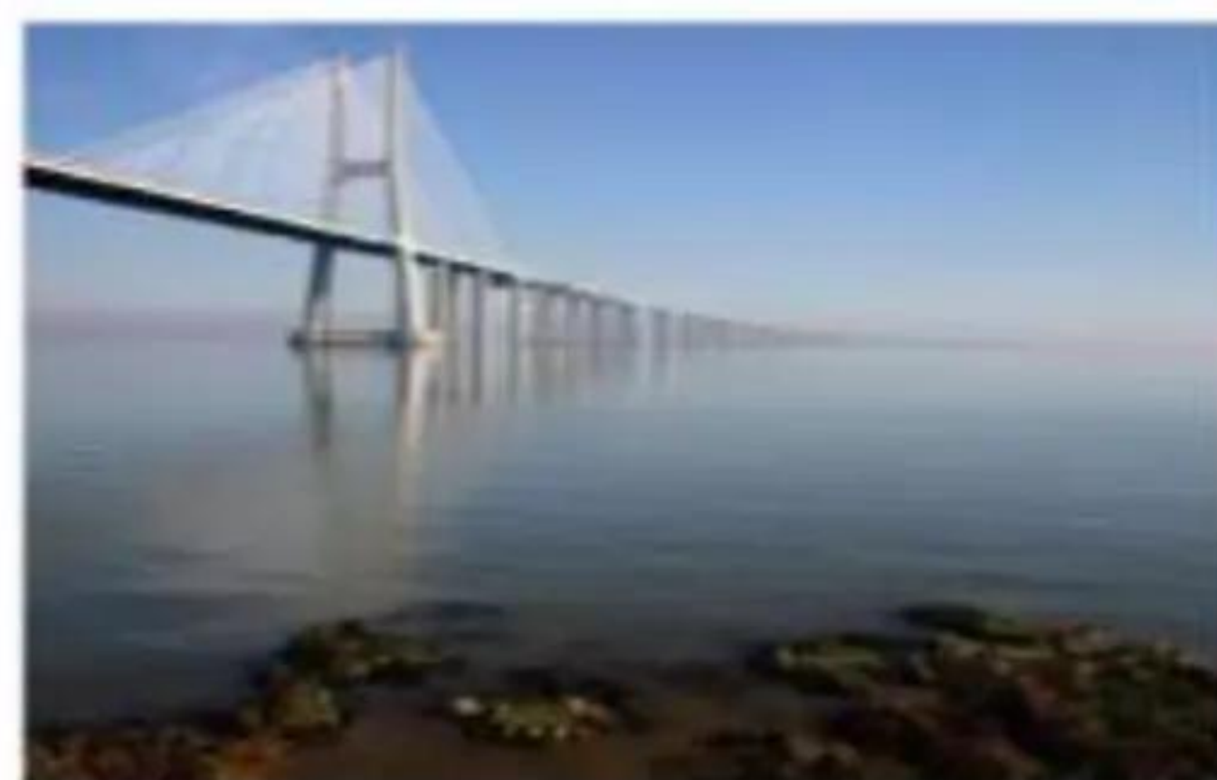
Ponte Vasco da Gama. Lisboa – Portugal
