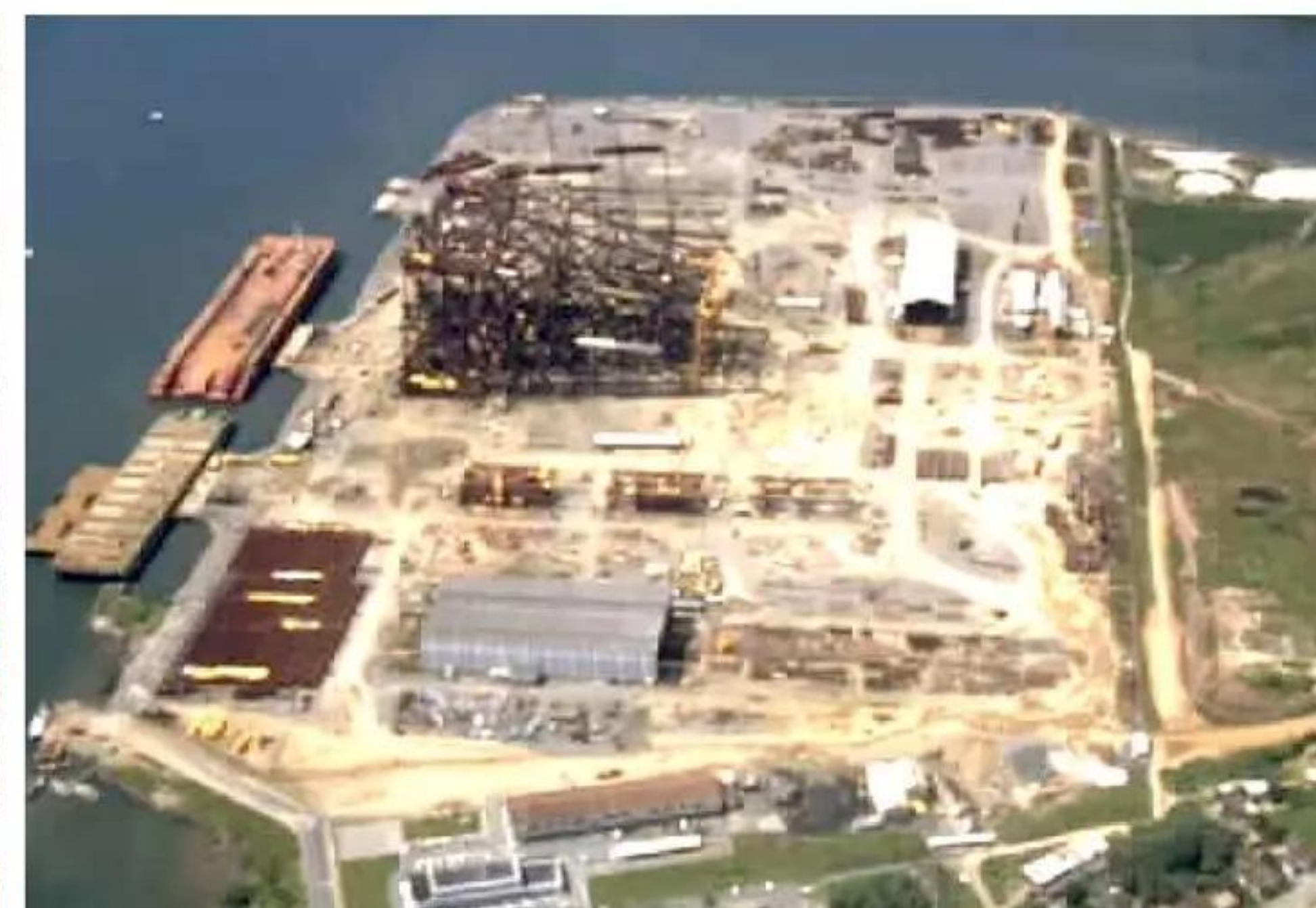
Fotos de construção do Estaleiro
