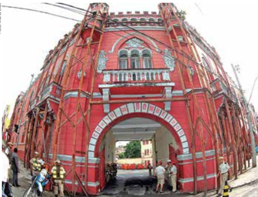
Recuperação do prédio do Corpo de Bombeiros e de três casarões no Centro Antigo de Salvador
