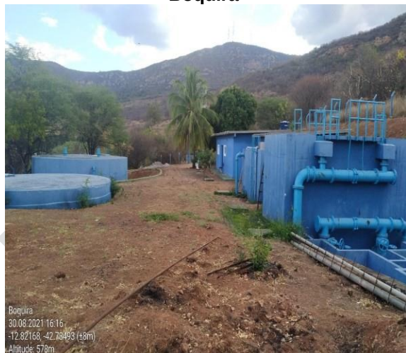
Figura 45 – Decantadores da ETA do Sistema Sede de Boquira
