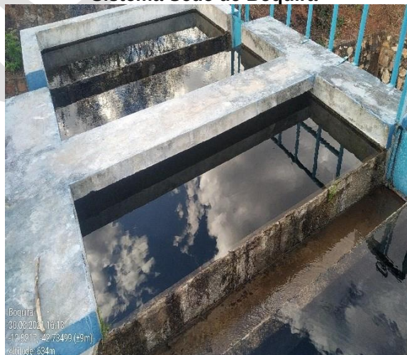
Figura 45 – Decantadores da ETA do Sistema Sede de Boquira
