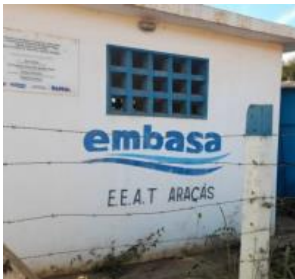
Figura 49 – EEAT do sistema Sede de Formosa do Rio Preto
