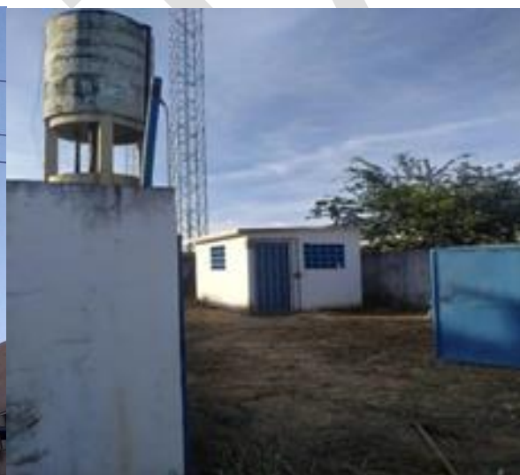
Figura 53 – Reservatório Santa Helena (Formosa do Rio Preto)
