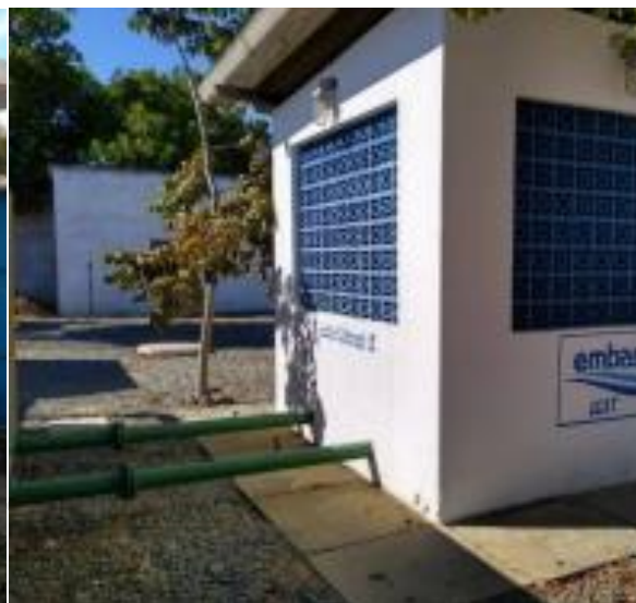
Figura 50 – EEAT do sistema Taguá (Cotegipe)
