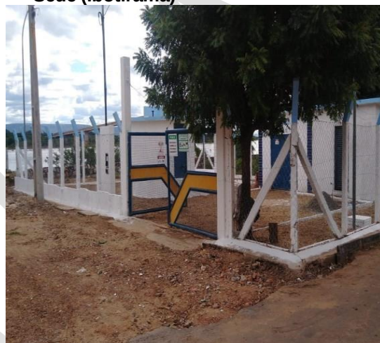
Figura 61 – EEE 03 do Sistema Sede (Ibotirama)
