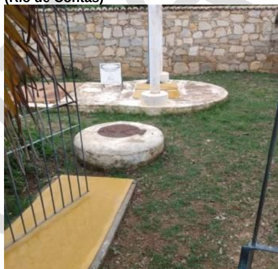
Figura 62 – EEE 02 do Sistema Sede (Rio de Contas)
