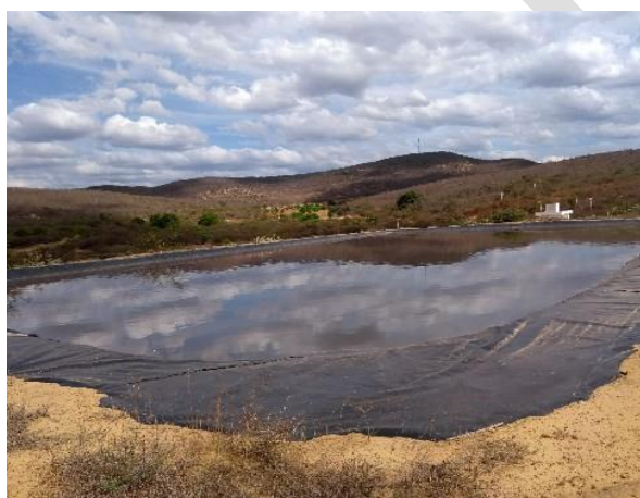
Figura 64 - Lagoa Anaeróbia – ETE Gentio do Ouro (Sistema Sede)
