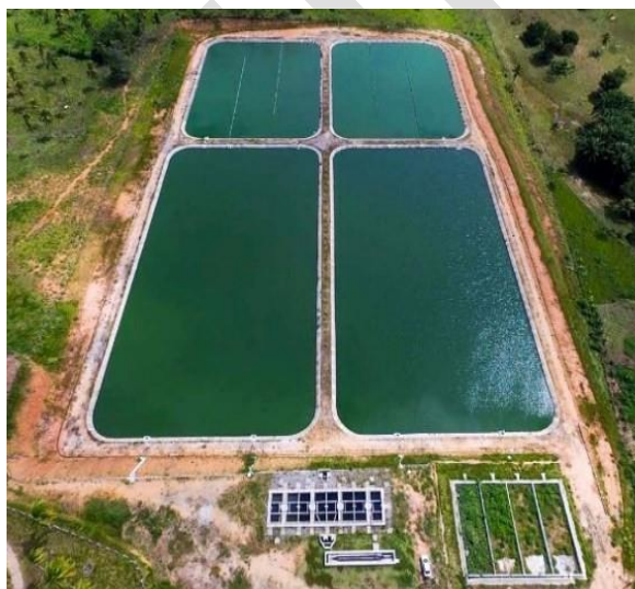
Figura 66 - Lagoa e leito de secagem da ETE do sistema Sede (Conde)
