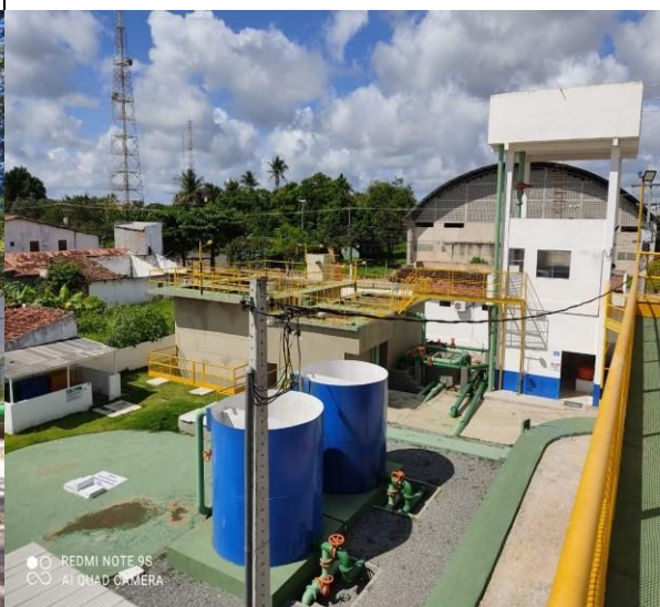
Figura 43 – ETA Sede (Entre Rios)
