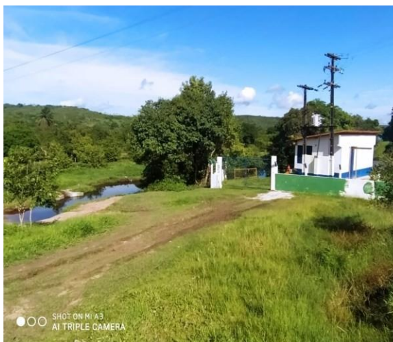
Figura 31 – Captação Entre Rios
