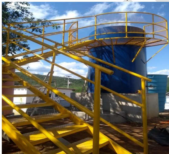
Figura 43 – Flocculadores da ETA do SAA Sede e Faustino de Iaçú
