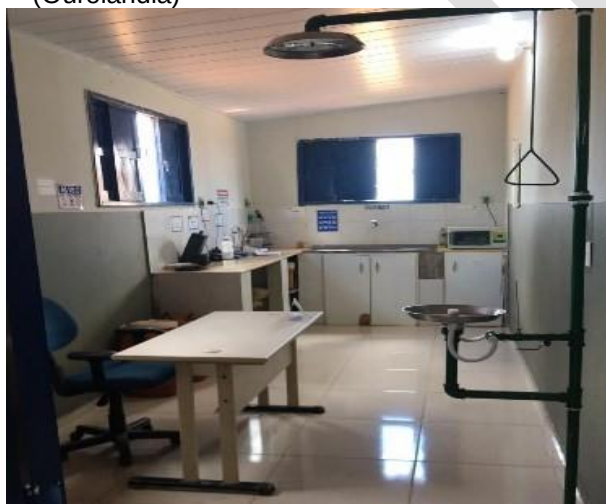
Figura 51 – Laboratório ETA SAA Sede (Ourolândia)
