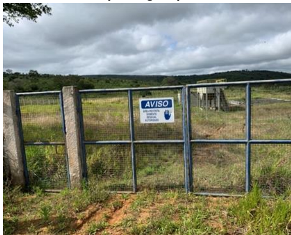
Figura 77 – ETE do Sistema Sede (Mirangaba)
