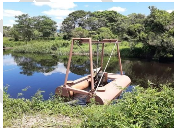
Figura 33 – Flutuante Captação Argoim
