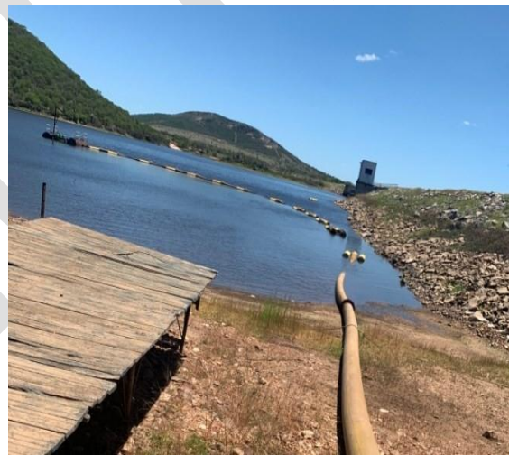
Figura 32 – Captação Barragem de Ponto Novo
