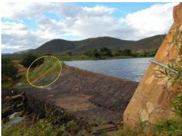
Figura 6 – Estado de conservação da barragem José Ferreira
