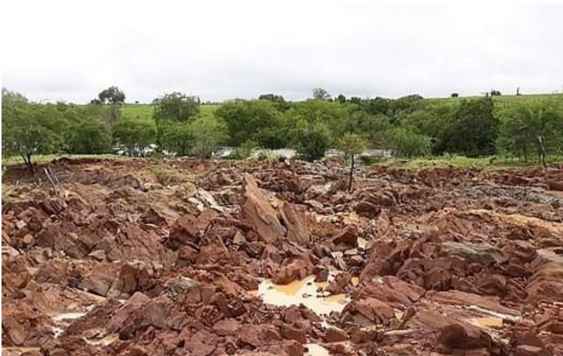
Figura 6 – Rompimento de Barragem em Pedro Alexandre
