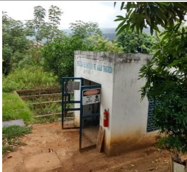
Figura 66 – EEAT (Sistema Sede – Andaraí)
