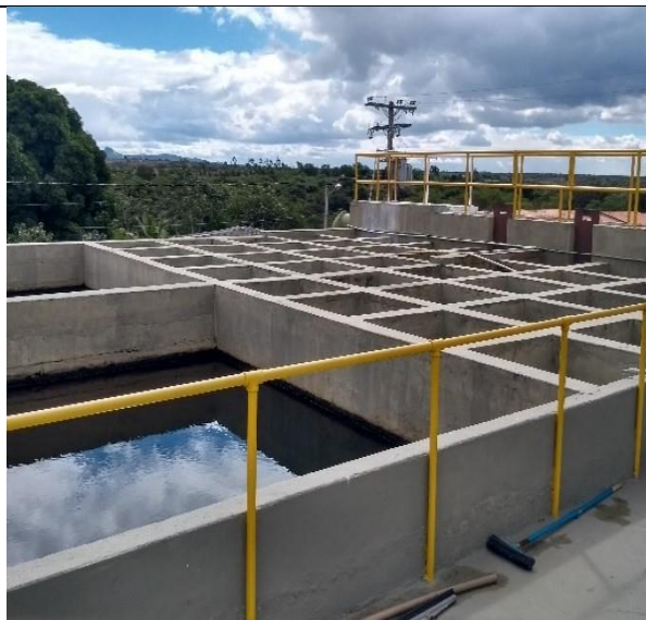
Figura 62 – Floculadores da ETA do SAA Sede e Faustino de laçu
