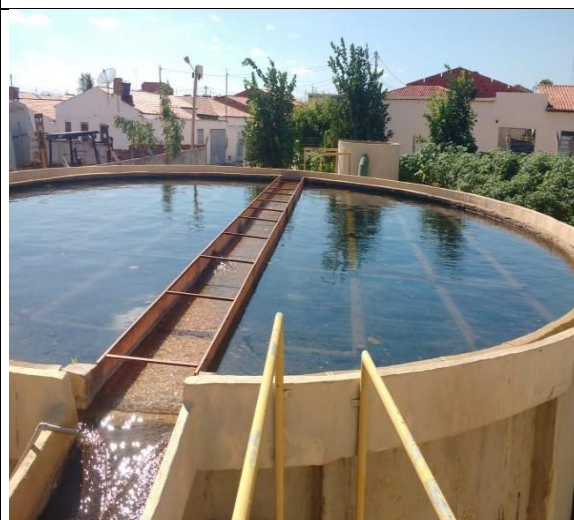
Figura 64 – Decantador da ETA do Sistema Sede de Abaré
