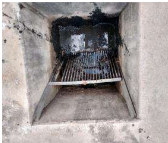
Figura 92 – Gradeamento da ETE do Sistema de Pedras Altas (Capim Grosso)
