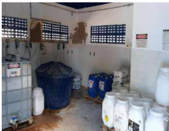
Figura 64 – Casa de Química da ETA do Sistema SDPSASF (Nova Fátima)
