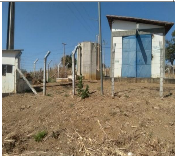
Figura 65 – EEAT do Sistema SRSA (Canápolis)
