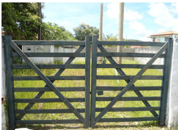
Figura 2.121 – Entrada do poço CSB3, no qual a equipe não teve acesso para verificação de suas condições
