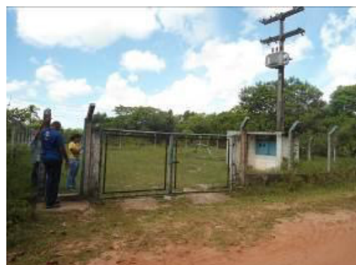
Figura 2.54 – Acesso para o poço CSB2
