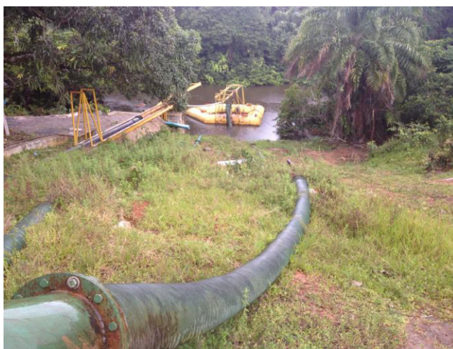
Figura 2.114 – Vista geral da área da captação SIAA Barra do Pojuca
