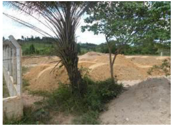
Figura 2.25 – Depósito de terra proveniente das obras de requalificação de acessos próximos à área do poço Manteiga 2
