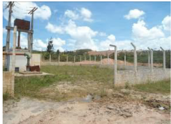
Figura 2.27 – Área do poço Manteiga 2 sem qualquer proteção
