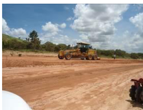
Figura 2.23 – Movimentação de terra na região do entorno do poço Manteiga 1
