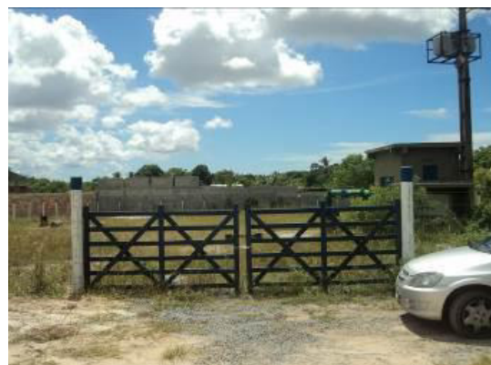
Figura 2.40 – Área onde está instalado o poço CSB7
