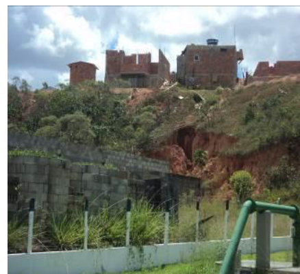
Figura 2.38 – Área de ocupação desordenada, próxima ao poço CSB5
