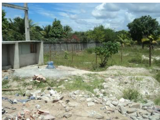
Figura 2.43 – Área do poço novo CSB10
