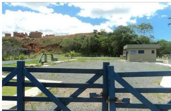
Figura 2.37 – Área onde está instalado o poço CSB5
