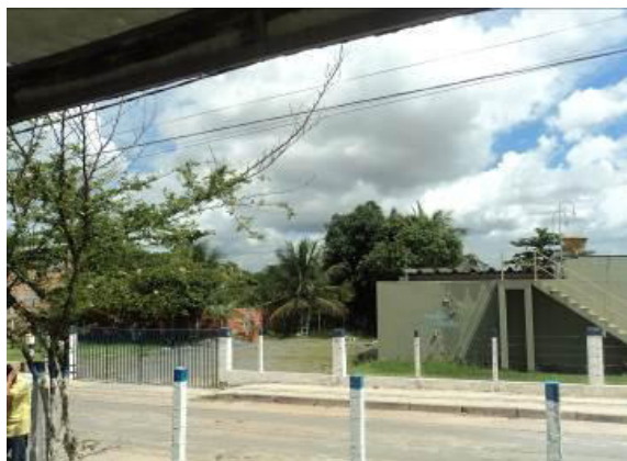
Figura 2.33 – Entrada da ETA do SIAA de Machadinho, onde está localizado o poço CSB1
