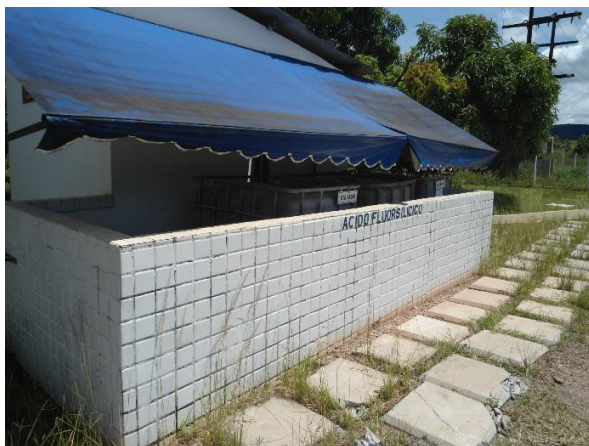
Figura 3.21 - Armazenamento e dosagem de ácido fluossilícico
