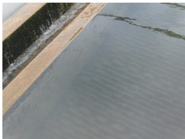
Figura 3.108 - Coleta da água decantada
