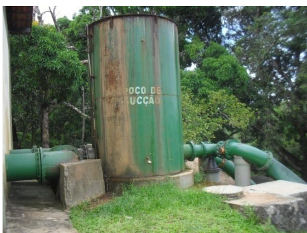
Figura 3.95 - Antigo poço de sucção da EEAB2
