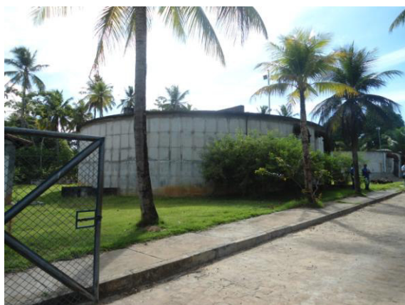
Figura 3.89 -RAP de 1.500 m 3 , utilizado como Poço de Sucção da EEAT2
