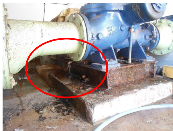
Figura 3.30 – Vazamentos verificados (em destaque)
