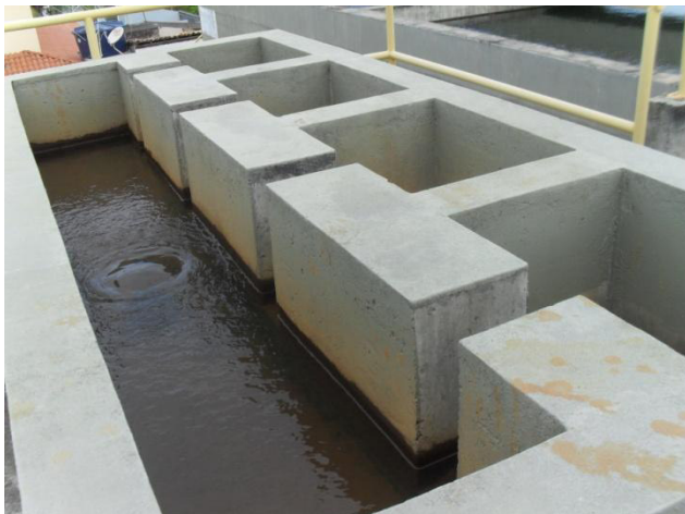
Figura 3.125 - Detalhes da Caixa Repartidora de Vazão (CRV)
