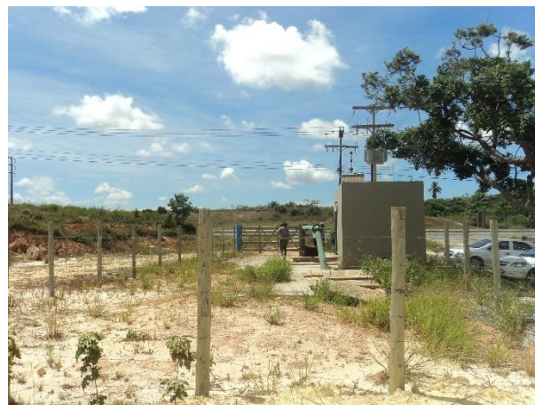
Figura 3.25 – Localização do CSB Urca, onde evidencia-se a precariedade da proteção do local
