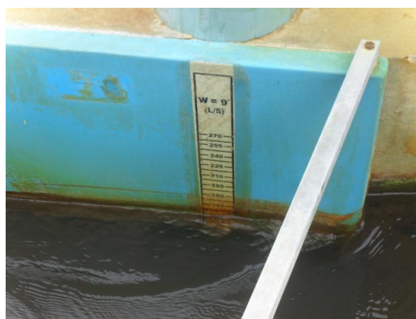
Figura 3.104 - Medição da vazão afluente à ETA
