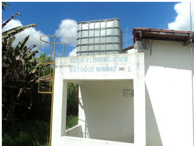
Figura 3.44 - Bombona de ácido fluossilícico situada na área externa
