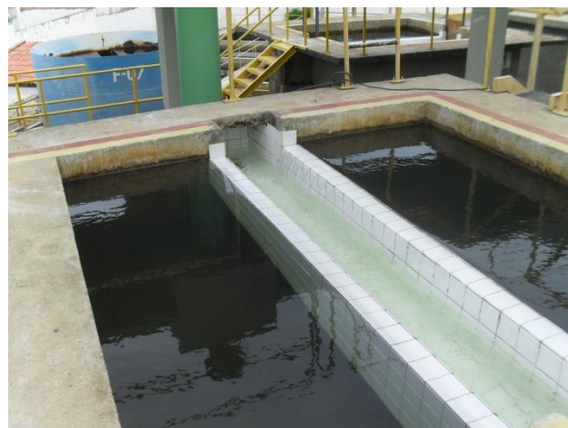
Figura 3.111 - Coleta de água clarificada nos dois tipos de filtros existentes na ETA de Barra do Pojuca.
