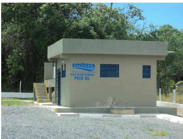
Figura 3.46 - Vista externa da unidade de tratamento do poço CSB5
