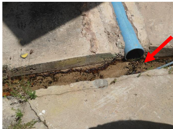
Figura 3.18 - Perdas de água identificadas na caixa de reunião
