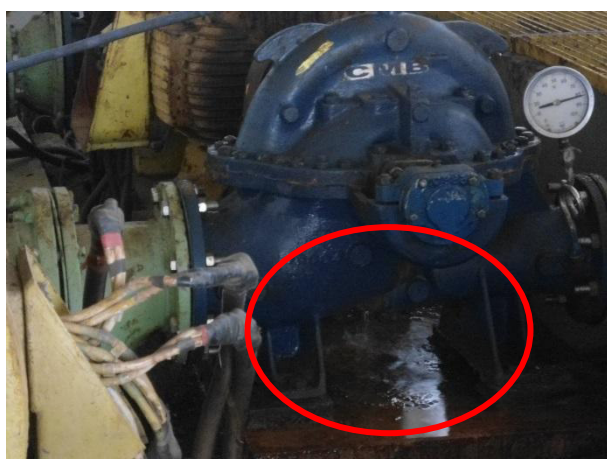
Figura 3.30 – Vazamentos verificados (em destaque)
