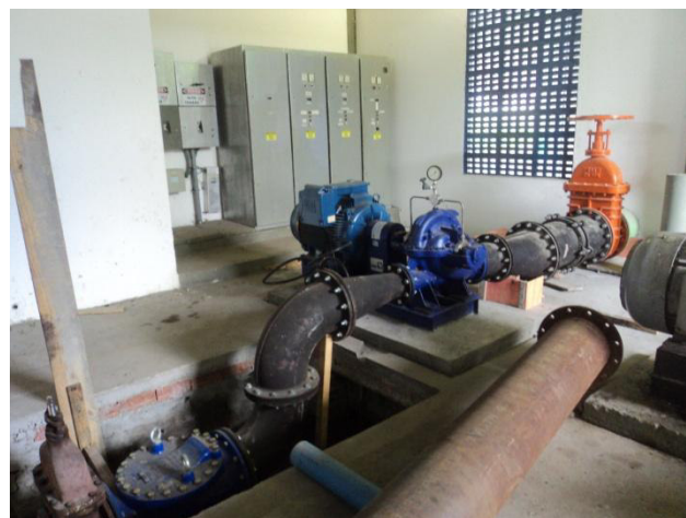
Figura 3.53 - Novo conjunto elevatório (em instalação)
