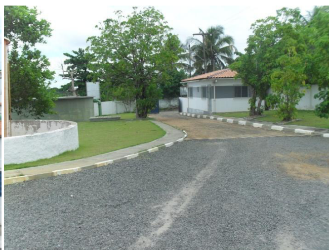
Figura 3.100 - Entrada da ETA de Barra do Pojuca
