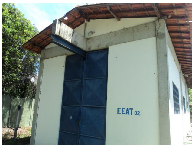
Figura 3.141 - Vista externa da EEAT2
