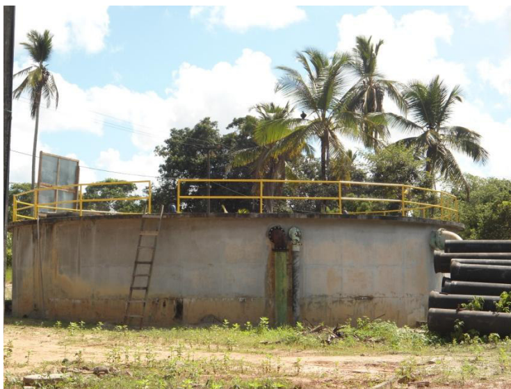
Figura 3.77 - Tanque de contato (400m 3 )
