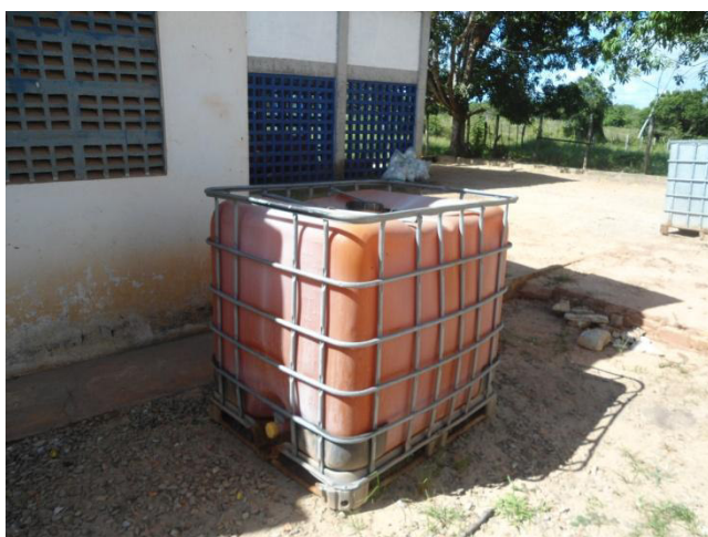
Figura 3.79 - Bombona de ácido fluossilícico, armazenada na área externa
