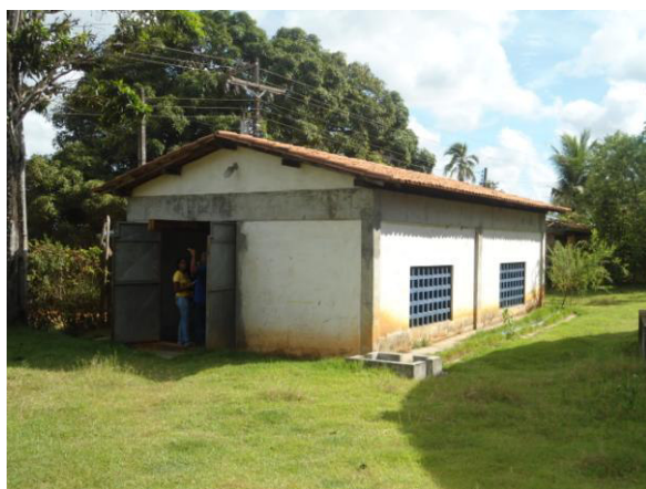
Figura 3.87 - Vista geral da EEAT2
