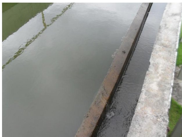
Figura 3.132 - Coleta do efluente sobrenadante dos adensadores de lodo
