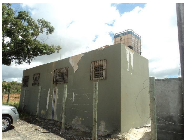
Figura 3.14 - Casa de química do poço da Urca
