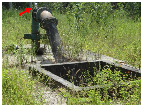
Figura 3.69 - Barriletes do poço CSB3 com destaque (em vermelho) para o medidor de pressão do mesmo
