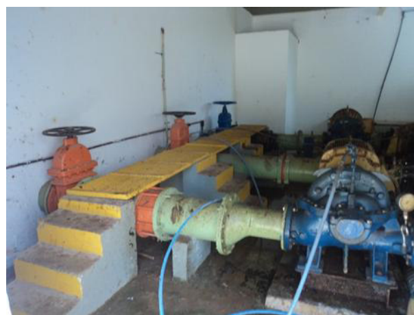
Figura 3.29 – Conjuntos motobomba. Destaque para os registros de controle do sistema, manômetros e passarela de acesso aos CMB.
