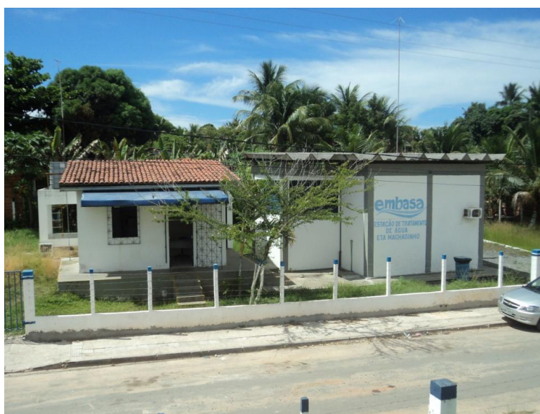
Figura 3.40 - Vista geral da ETA de Machadinho
