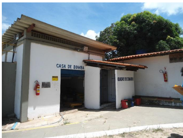
Figura 3.27 – Estrutura de abrigo das bombas e do quadro de comando
