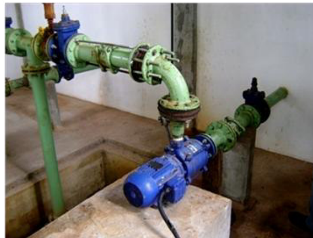
Figura 3.151 - Detalhe dos conjuntos motobomba que compõem a EEAT4
