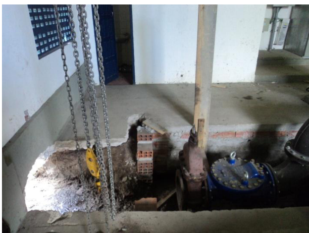
Figura 3.58 - Obras para a implantação do novo conjunto elevatório
