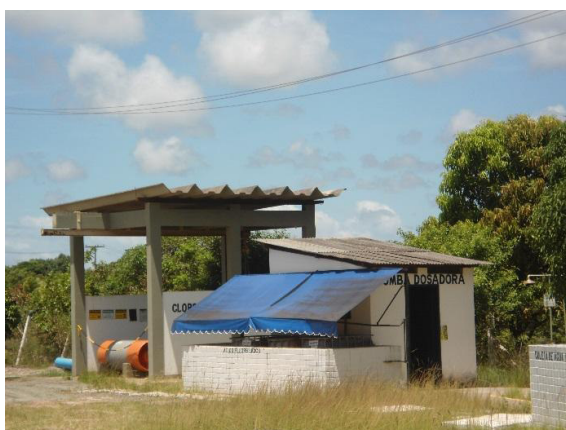
Figura 3.19 - Local de dosagem / armazenamento dos produtos químicos
