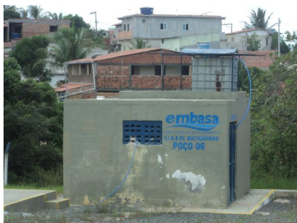
Figura 3.48 - Vista externa da unidade de tratamento do poço CSB6
