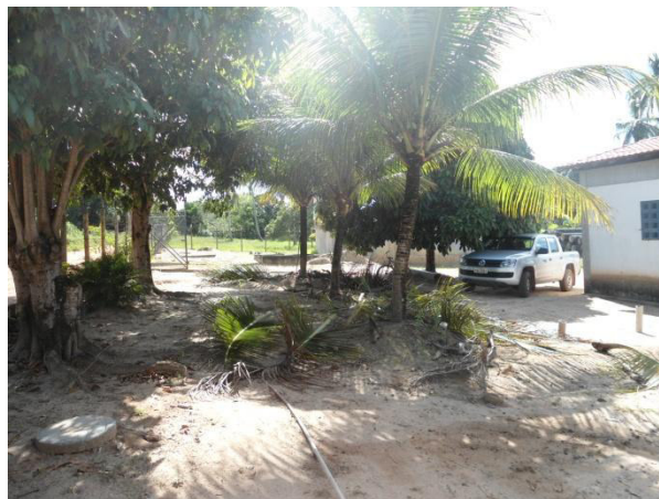
Figura 3.74 - Área interna da ETA de Jordão
