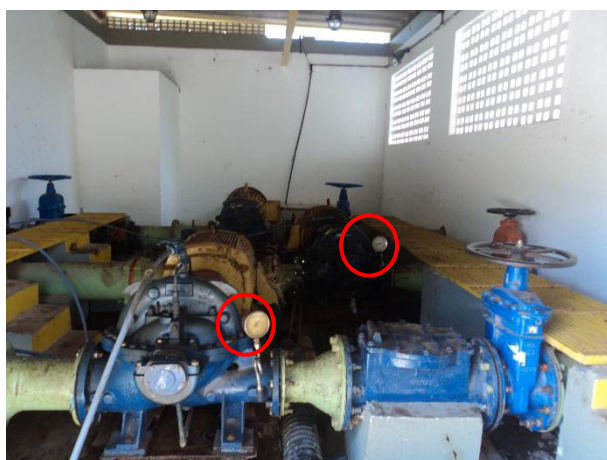
Figura 3.29 – Conjuntos motobomba. Destaque para os registros de controle do sistema, manômetros e passarela de acesso aos CMB.
