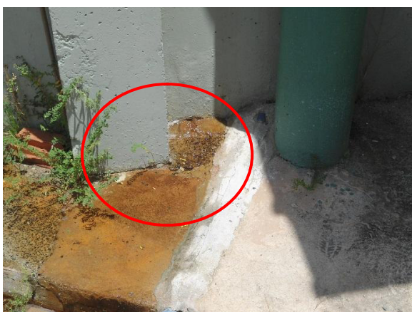
Figura 3.18 - Perdas de água identificadas na caixa de reunião
