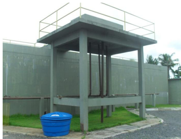
Figura 3.126 - Vista da Caixa Repartidora de Vazão (CRV)
