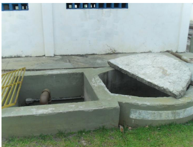
Figura 3.129 - Poço de sucção da Estação Elevatória de Efluentes 4 (EEE4)
