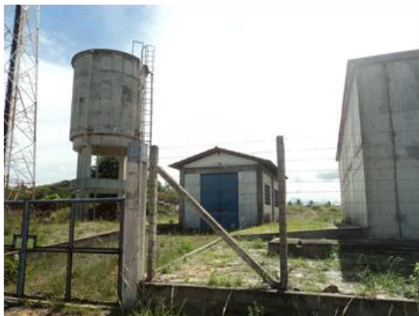
Figura 3.149 - Vista geral da área onde está instalada a EEAT4
