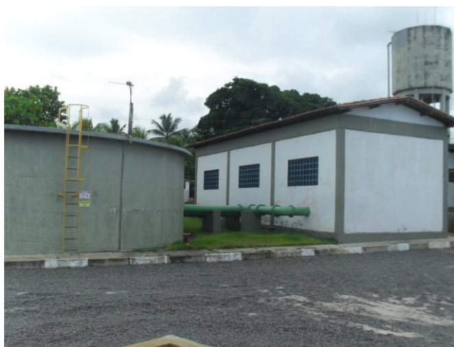
Figura 3.137 - Vista geral da EEAT1N, implantada junto ao RAP de 400 m 3 (poço de sucção).
