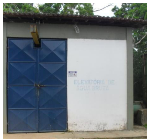
Figura 3.96 - Área externa da casa de bombas da EEAB2
