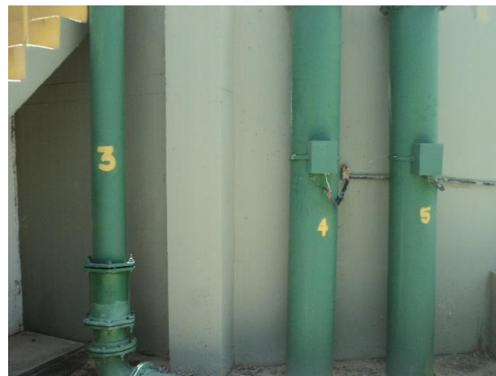
Figura 3.17 - Adutoras da água bruta captada nos poços
