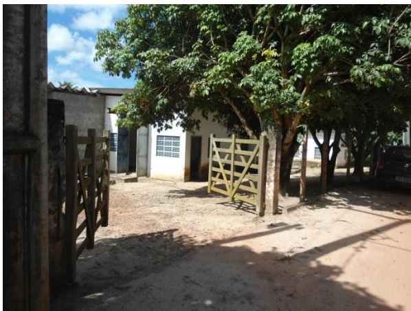
Figura 3.73 - Entrada da ETA de Jordão
