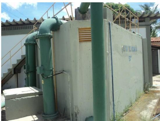
Figura 3.17 - Adutoras da água bruta captada nos poços
