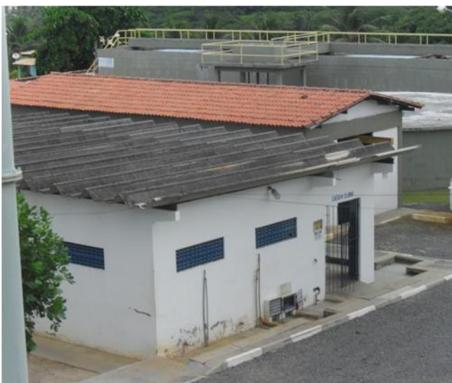
Figura 3.114 - Vista geral da edificação que abriga as Casas de Química e de Cloração
