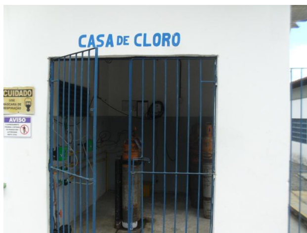
Figura 3.122 - Vista externa da Casa de Cloração
