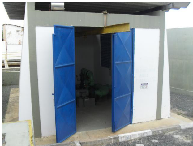
Figura 3.138 - Vista externa da EEAT1
