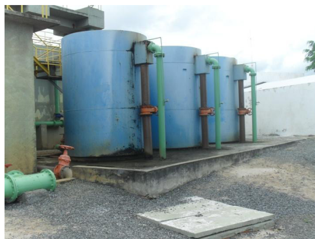
Figura 3.109 - Filtros russos de seção circular (aço carbono)
