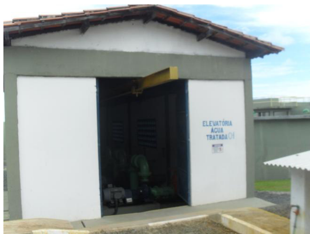
Figura 3.135 - Vista externa da EEAT1N
