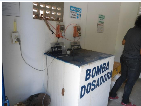
Figura 3.22 - Bombas dosadoras de ácido fluossilícico
