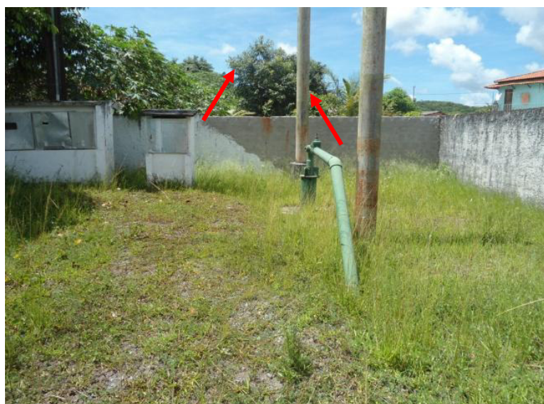
Figura 3.153 – Poço CSB3 (vista através portão de acesso), com destaque para as traves de içamento do CMB
