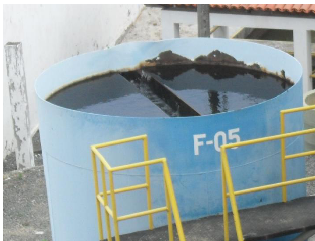
Figura 3.111 - Coleta de água clarificada nos dois tipos de filtros existentes na ETA de Barra do Pojuca.
