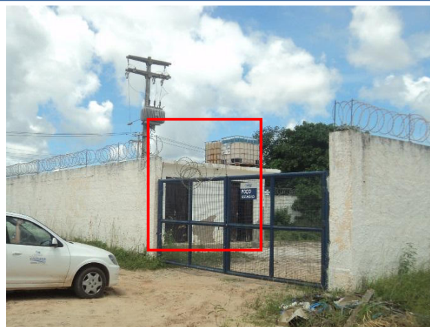
Figura 3.13 - Poço Estádio - Casa de química em destaque
