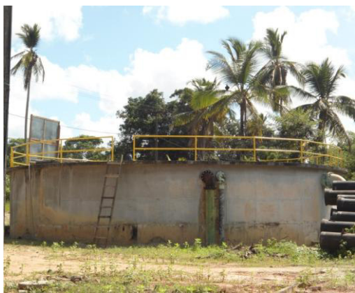
Figura 4.17 – Tanque de contato de 400 m³
