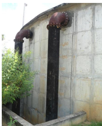
Figura 4.20 – Tubulações de chegada nos RAP's 1.500
