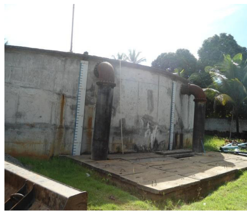
Figura 4.20 – Tubulações de chegada nos RAP's 1.500
