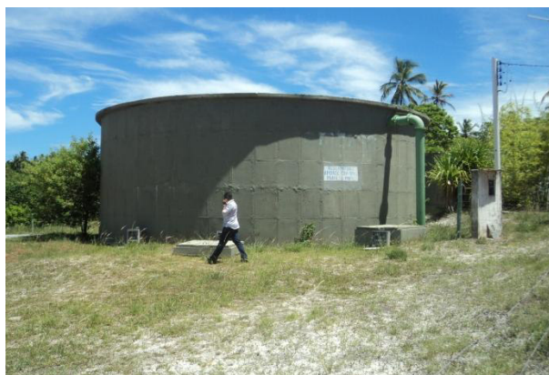
Figura 4.37 – Reservatório de 500 m 3 (RAP 500)
