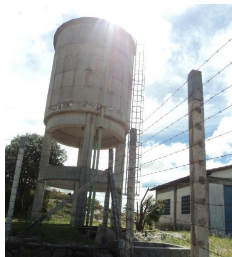
Figura 4.40 – Reservatório Elevado de 70 m 3 (REL 70)
