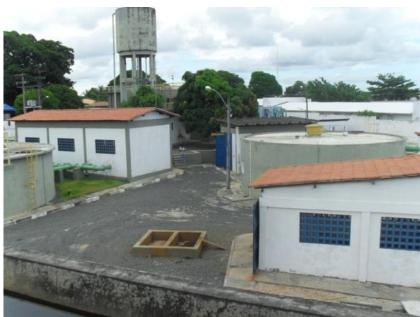
Figura 4.31 – Vista geral da ETA de Barra do Pojuca
