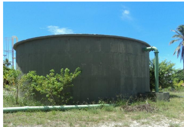
Figura 4.37 – Reservatório de 500 m 3 (RAP 500)
