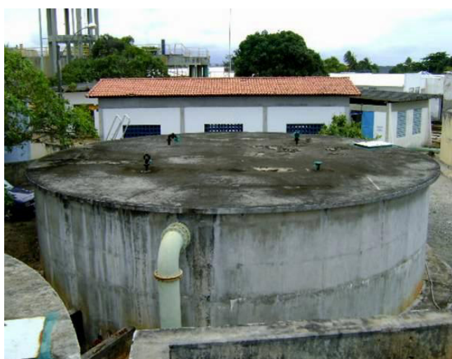
Figura 4.33 – Reservatórios Apoiados (RAP's) de 400 m³ (à esquerda) e 500 m³ (à direita)
