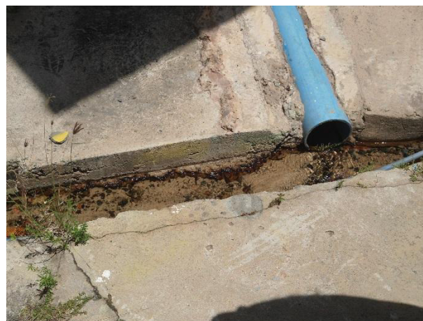
Figura 4.5 – Perdas de água identificadas na caixa de reunião
