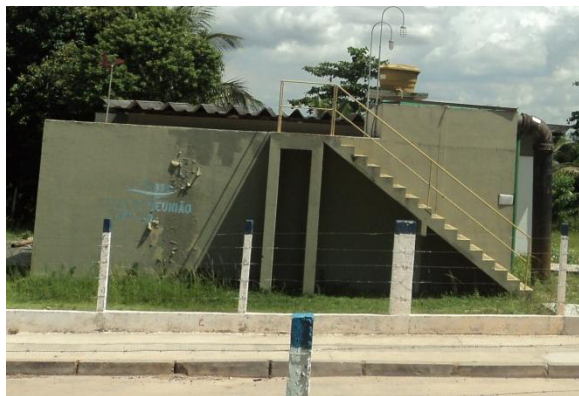
Figura 4.8 – Reservatório de reunião de 150 m³
