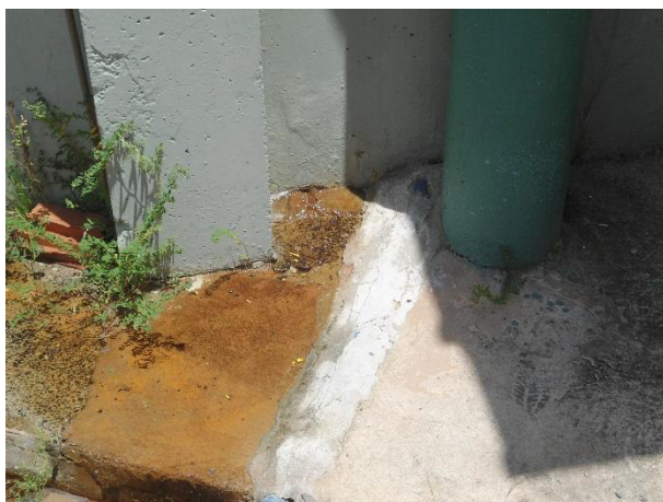
Figura 4.5 – Perdas de água identificadas na caixa de reunião
