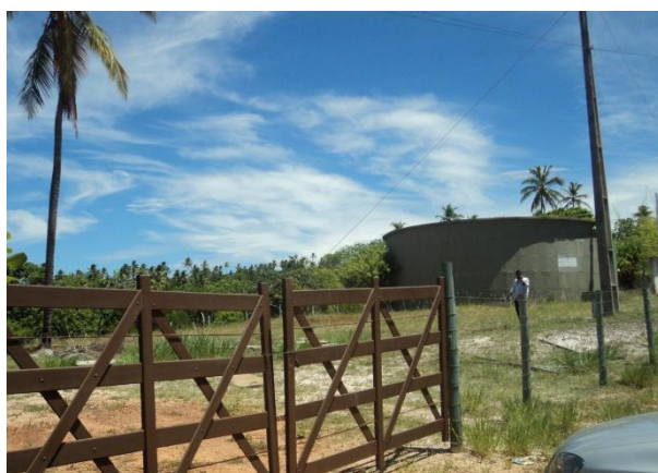
Figura 4.35 – Área de reservação em Praia do Forte
