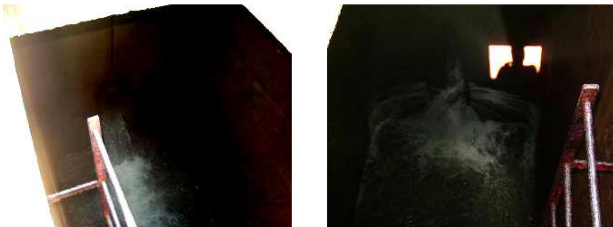
Figura 4.13 – Vista interna das duas câmaras do RAP 900 com nível d'água bem baixo
