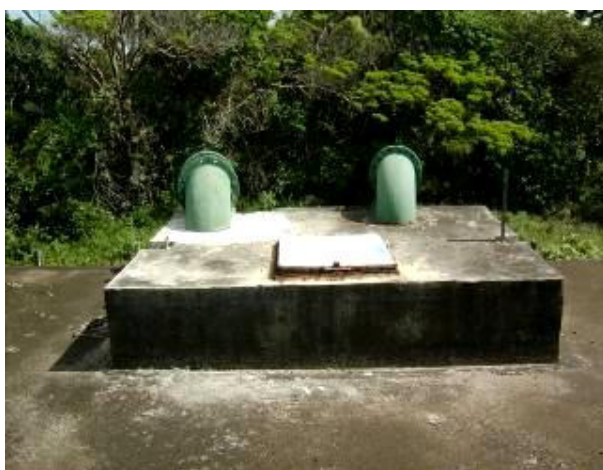
Figura 4.10 – Vistas externa e interna da caixa que recebe a vazão afluyente ao RAP 900, a partir da qual, esta é distribuída nas duas câmaras de reservação da unidade
