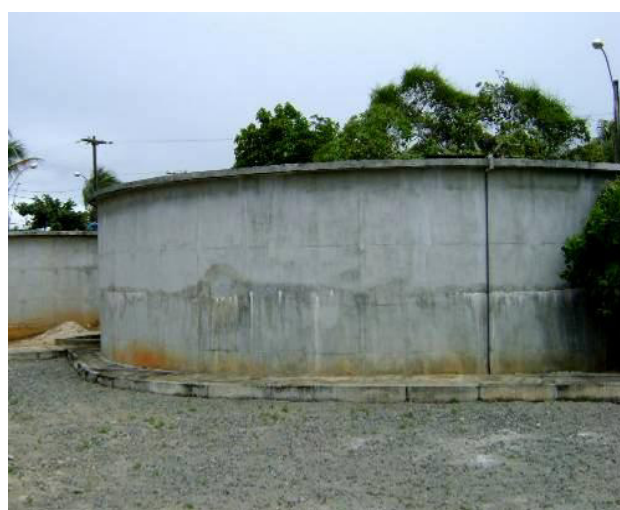
Figura 4.33 – Reservatórios Apoiados (RAP's) de 400 m³ (à esquerda) e 500 m³ (à direita)
