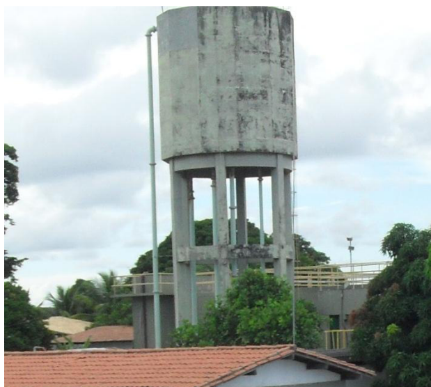
Figura 4.34 – REL de 150 m³ (Lavagem dos Filtros)
