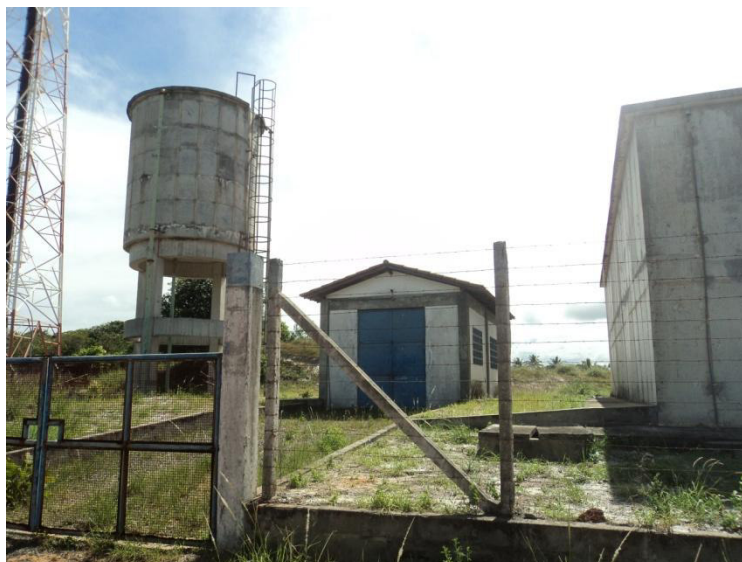
Figura 4.38 – Área de reservação em Imbassai
