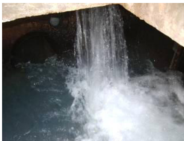
Figura 4.10 – Vistas externa e interna da caixa que recebe a vazão afluyente ao RAP 900, a partir da qual, esta é distribuída nas duas câmaras de reservação da unidade
