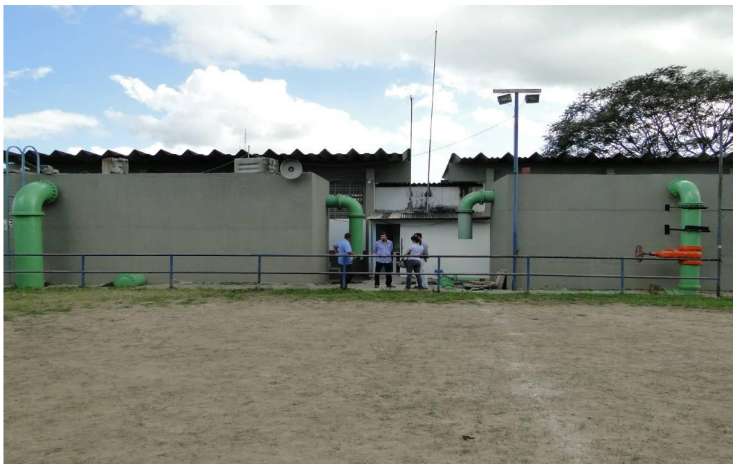
Figura 2.6 - Vista das câmaras de 75 m 3 na área do RZB-II de Candeias
