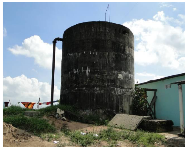
Figura 2.12 - Reservatório de 100 m³ em Campinas
