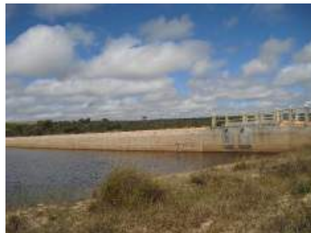
Figura 7.4 - Barragem dentro do reservatório de Apertado
