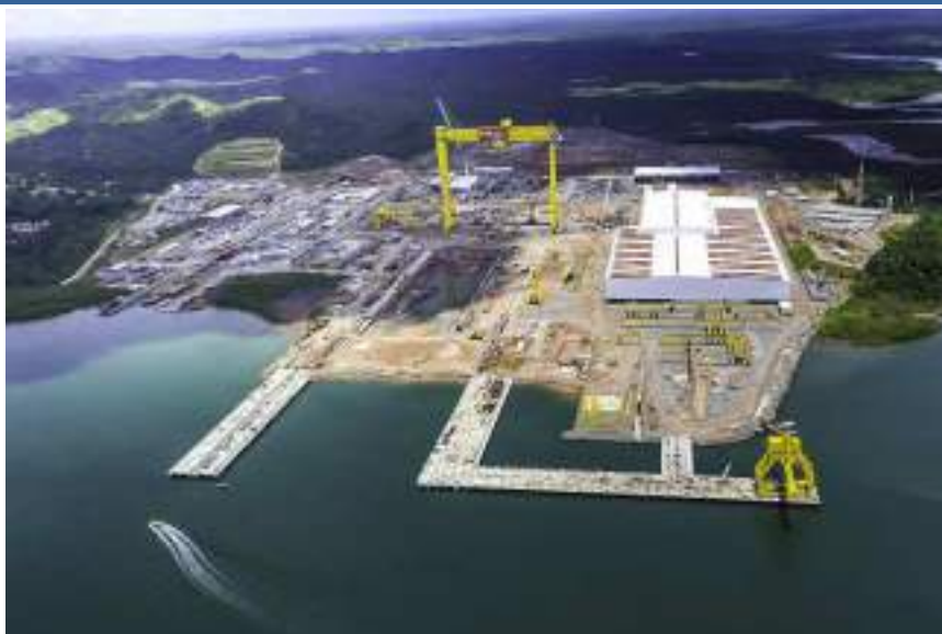
Figura 7.32 – Construção (paralisada em 2015) do estaleiro Enseada de Paraguaçu
