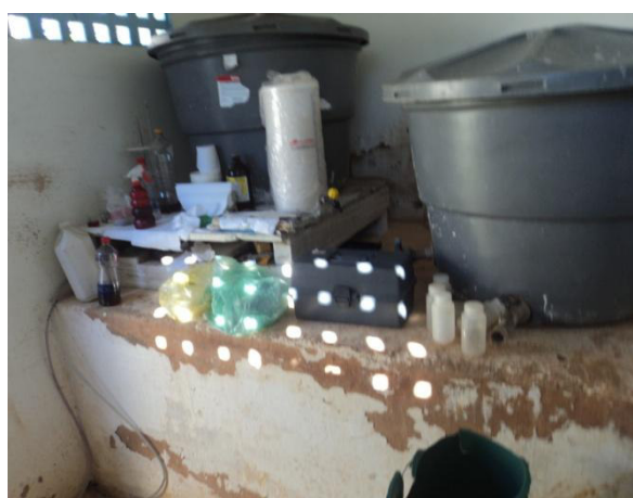
Figura 4.45 - SAA Futurama - Vista da Casa de química. Necessidade de espaço adequado para o operador.
