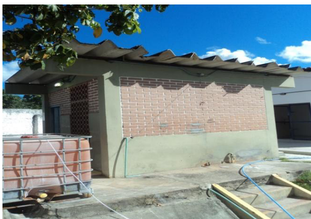
Figura 4.8 - Casa de Cloração – Vista das instalações.
