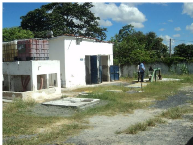
Figura 4.6 - Vista geral das instalações da EEB8
