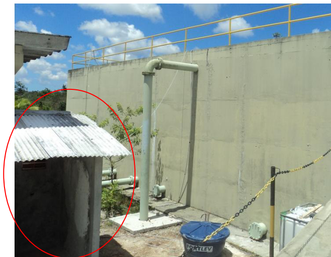
Figura 4.35 - Construção dos abrigos para os tanques utilizados na dosagem dos produtos químicos.
