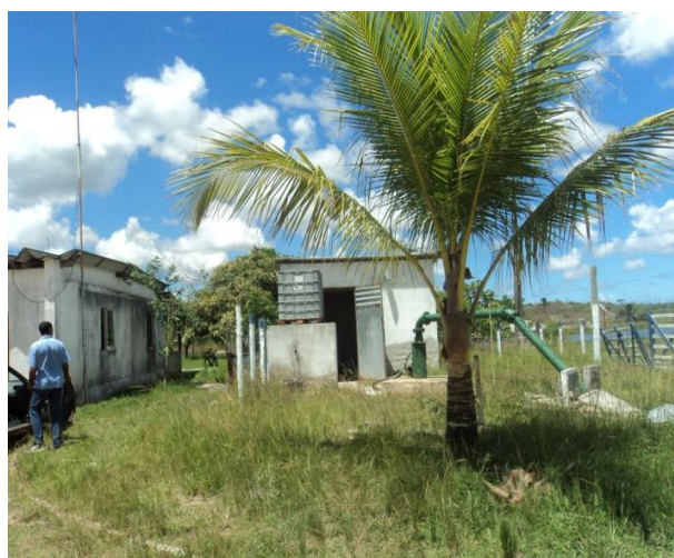
Figura 4.7 - Vista geral das instalações da EEB10.
