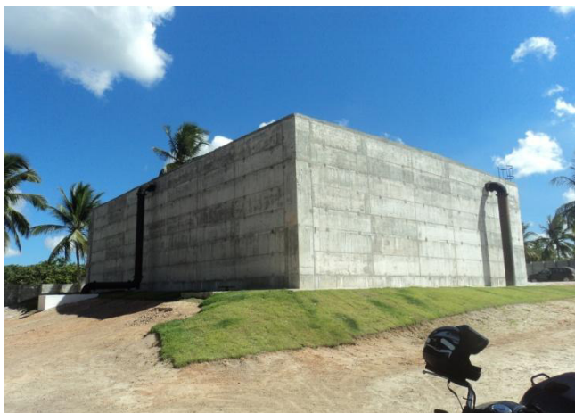
Figura 4.30 - Poço de Sucção/RAD 2 – 1500m 3 .
