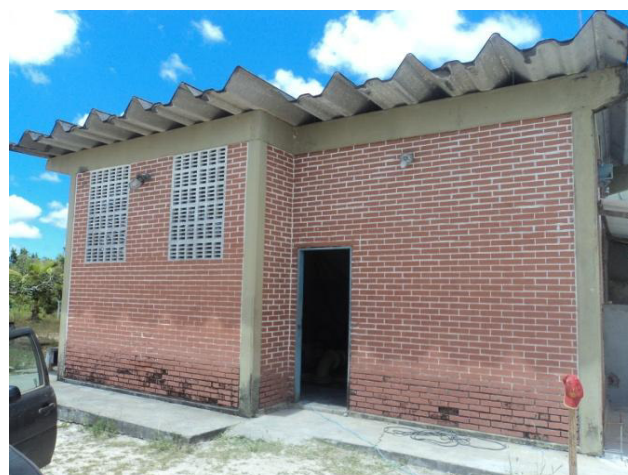
Figura 4.40 - EET – Vistas das instalações.
