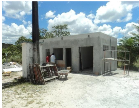
Figura 4.34 - Casa de química nova em construção. Espaço para o operador e depósitos de produtos químicos
