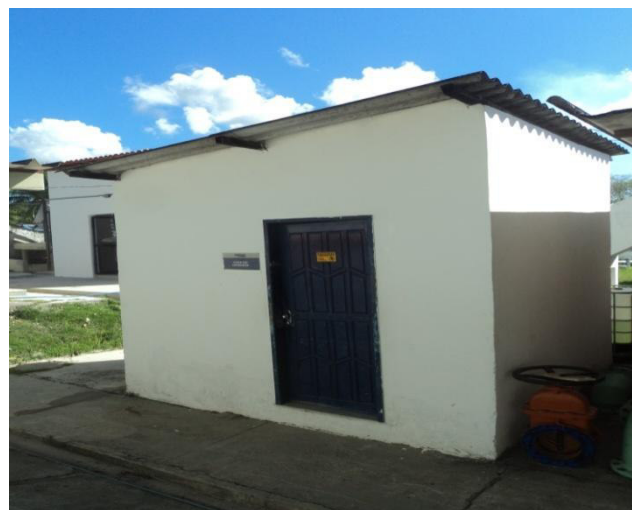
Figura 4.15- Casa do operador.
