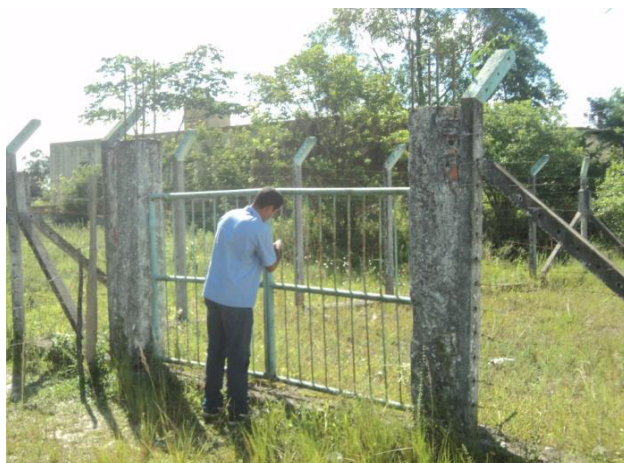
Figura 4.5 - Vista geral das instalações da EEB7
