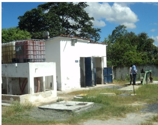
Figura 4.16- Casa de Química da área do Poço CSB8 - Vista das instalações.
