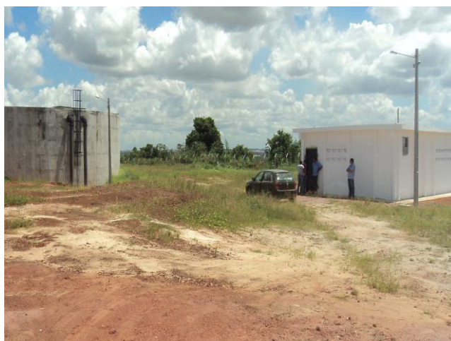
Figura 4.22 - Vista da área do RAD 1.500m³ e Casa de química – Zona 3.
