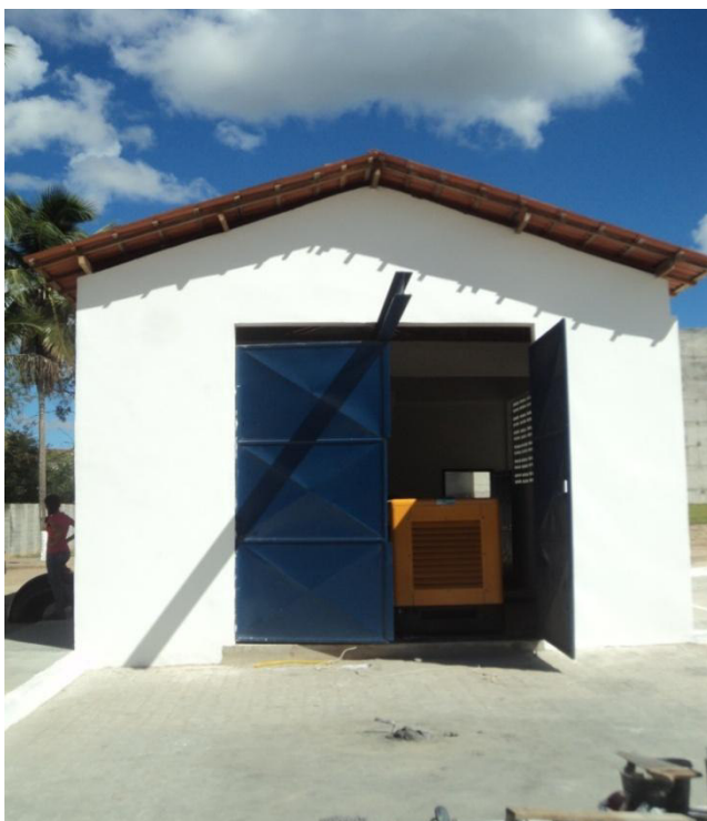
Figura 4.28 - EET2 – Vista das instalações.
