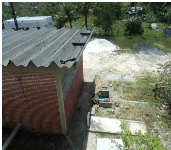
Figura 4.36 - Vista da Área da ETA.
