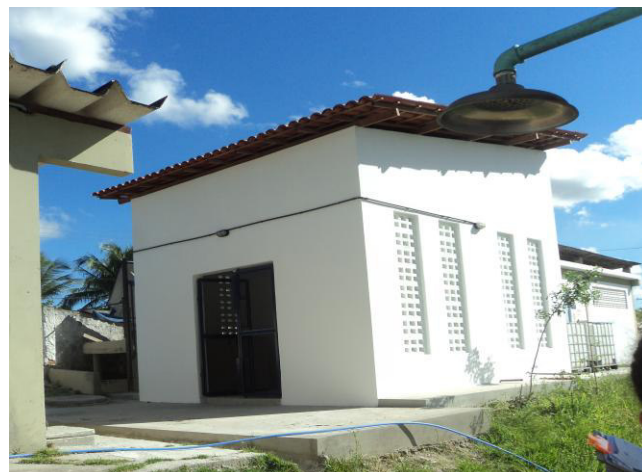
Figura 4.11 - Casa de Química nova. Local para Barrilha, e ao fundo, local para Ácido Fluossilícico.
