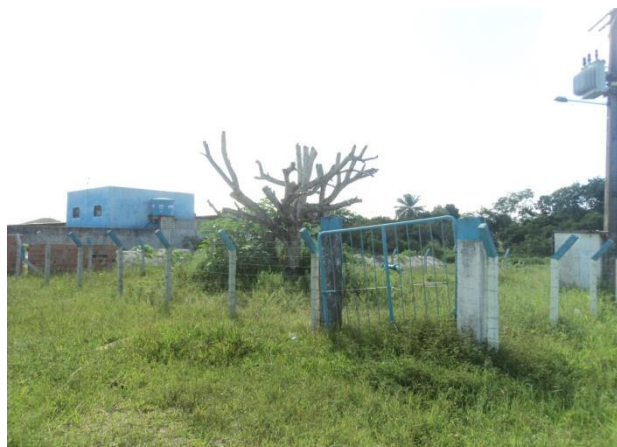
Figura 4.4 - Vista geral das instalações da EEB5
