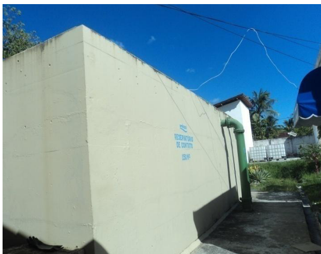
Figura 4.24- Poço de sucção da EET1 - 158m³.
