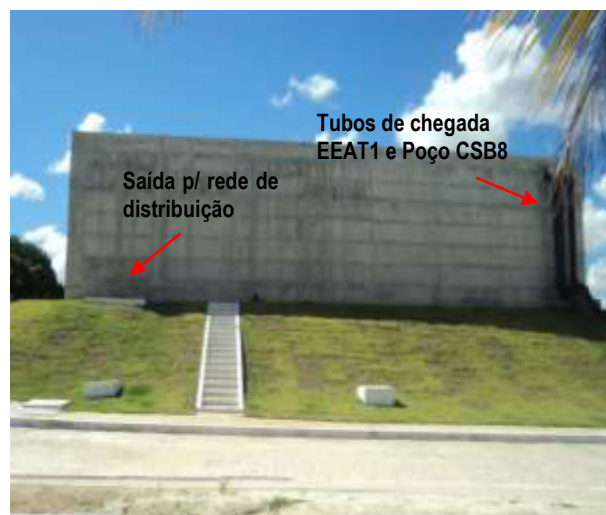
Figura 5.6 - Reservatório Apoiado de Distribuição 1.500m³ - RAD1 (Zona 1). Vista das tubulações de entrada e caixa de saída.
