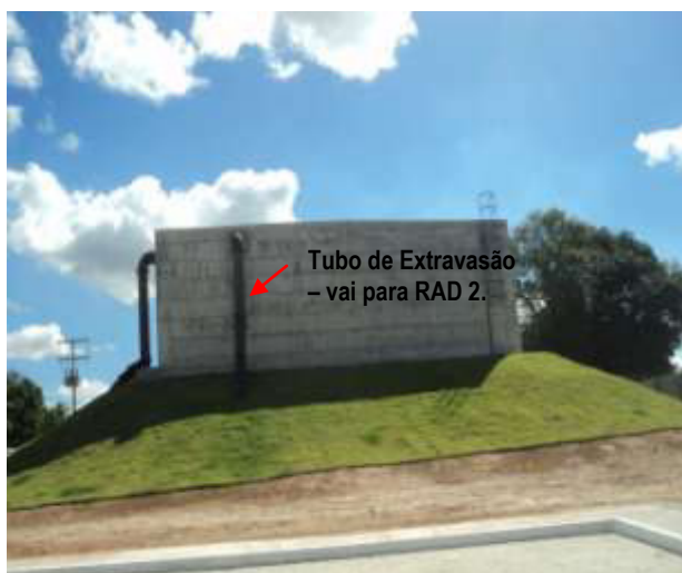
Figura 5.5 - Reservatório Apoiado de Distribuição 1.500m³ - RAD1 (Zona 1). Vista das tubulações de entrada e extravasão.
