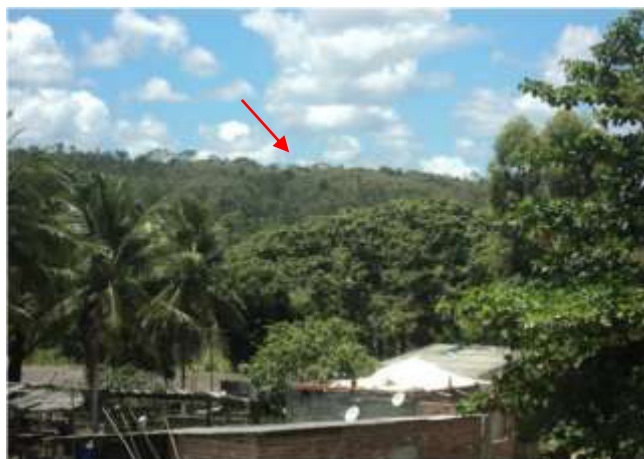
Figura 5.17 - RAD 150m³ – Reservatório Apoiado de Distribuição
