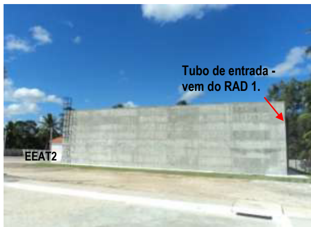
Figura 5.7 - Vista do Reservatório Apoiado de Distribuição 1.500m³ - RAD2 (Zona 2).
