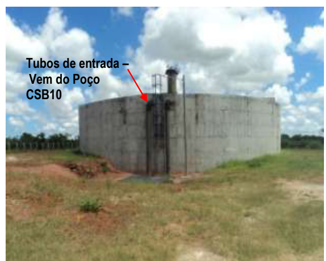
Figura 5.12 - Reservatório Apoiado de Distribuição 1.500m³ - RAD3 (Zona 3) - Tubulações de entrada.
