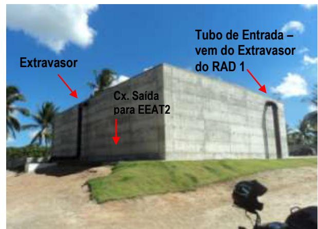
Figura 5.8 - Reservatório Apoiado de Distribuição 1.500m³ - RAD2 (Zona 2) – Tubulações de entrada e extravasor.
