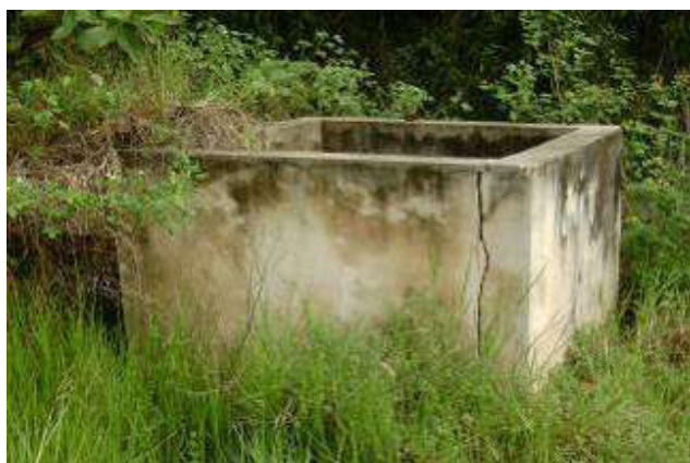
Figuras 6.56 e 6.57 – Caixa de registro instalada no local da travessia da Linha Tronco da Zona 1 sob a BA-099, sem tampa e apresentando estrutura bastante comprometida, com presença de rachaduras
