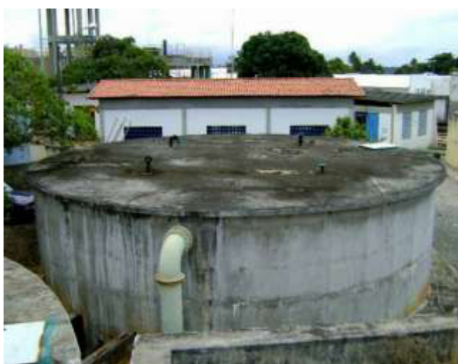
Figura 6.29 e Figura 6.30 - Reservatórios Apoiados (RAP's) de 400 m³ (à esquerda) e 500 m³ (à direita)
