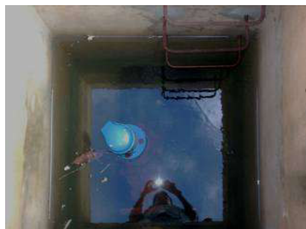
Figuras 6.58 e 6.59 – Caixa de ventosa da Linha tronco da Zona 1, sem tampa e com água à meia seção da caixa
