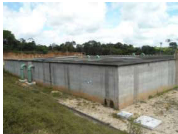
Figura 6.50 - Reservatórios apoiados com capacidade de 2.000 m 3 cada (RAPs 2000)
