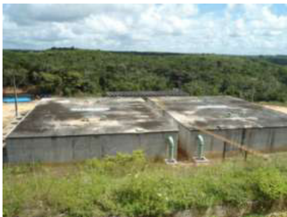
Figura 6.50 - Reservatórios apoiados com capacidade de 2.000 m 3 cada (RAPs 2000)
