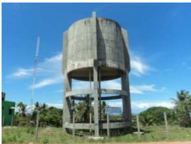
Figura 6.39 - REL de 250 m³ (Tererê)
