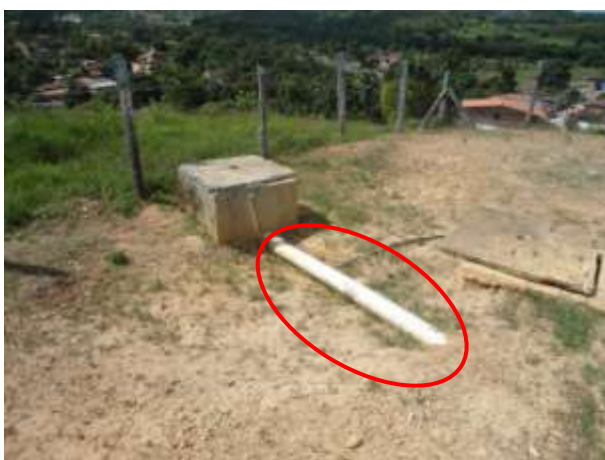
Figura 6.21 e Figura 6.22 - Área ao entorno do RAP 100, detalhe em vermelho tubulação de saída da água tratada para rede de distribuição
