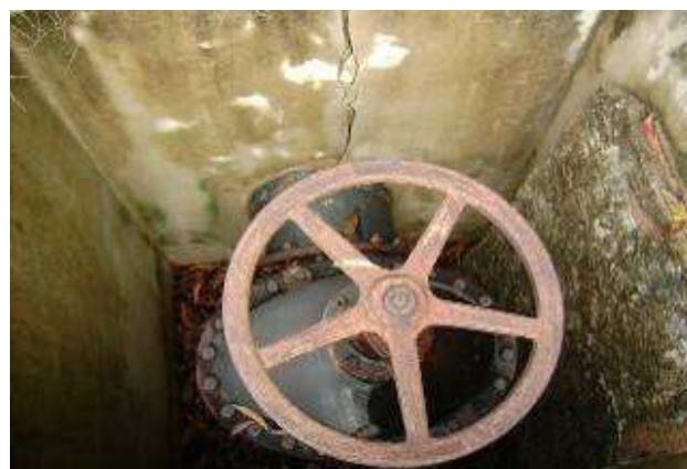
Figuras 6.56 e 6.57 – Caixa de registro instalada no local da travessia da Linha Tronco da Zona 1 sob a BA-099, sem tampa e apresentando estrutura bastante comprometida, com presença de rachaduras
