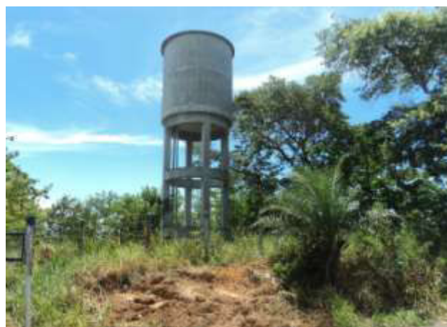
Figura 6.40 - REL de 70 m³ (Malhada)
