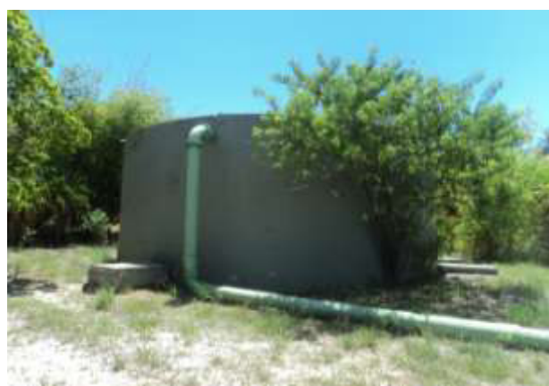
Figura 6.33 - Reservatório de 300 m 3 (RAP 300)
