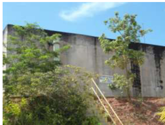
Figuras 6.52 e 6.53 - Reservatório apoiado para lavagem dos filtros com capacidade de 577 m 3 (RAP – RLF 577)
