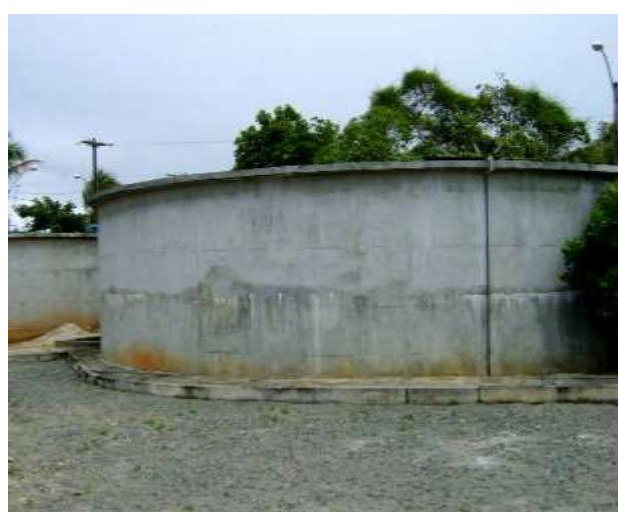
Figura 6.29 e Figura 6.30 - Reservatórios Apoiados (RAP's) de 400 m³ (à esquerda) e 500 m³ (à direita)
