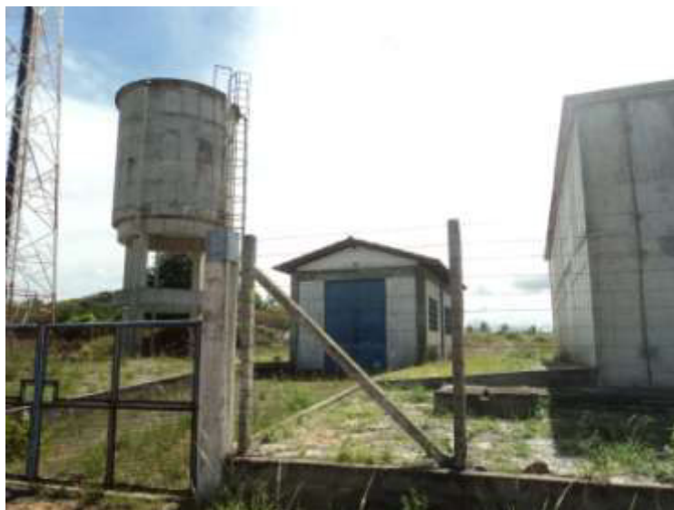
Figura 6.36 - Área de reservação em Imbassai
