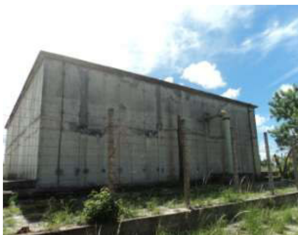
Figura 6.37 - Reservatório Apoiado de 1.000 m 3 (RAP 1.000)
