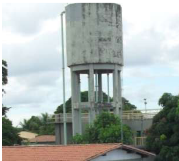
Figura 6.31 - REL de 150 m³ (Lavagem dos Filtros)
