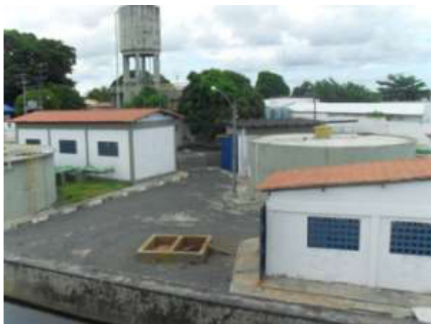
Figura 6.27 - Vista geral da ETA de Barra do Pojuca
