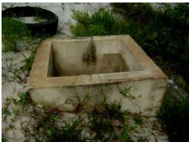
Figuras 6.58 e 6.59 – Caixa de ventosa da Linha tronco da Zona 1, sem tampa e com água à meia seção da caixa
