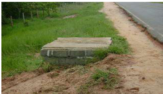
Figura 6.55 – Caixa de registro instalada no local da travessia da Linha Tronco para Zona 2, junto a estrada que interliga Canoas a Porto de Sauípe
